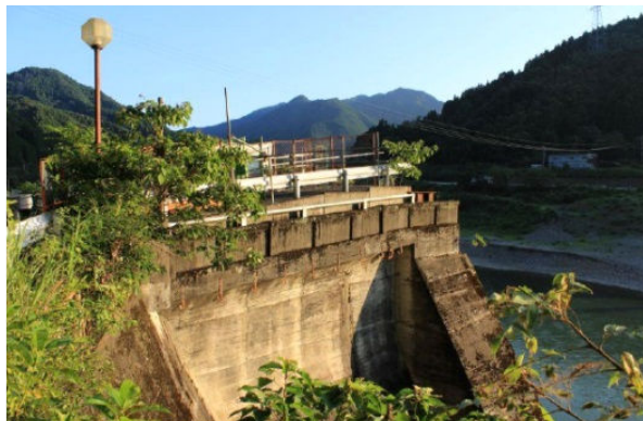
右岸残存部のダム軸を下流から望む
