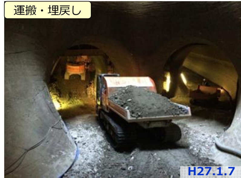
導水トンネル埋戻し第3期完了
