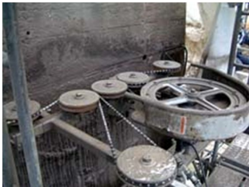
コンクリート切断
