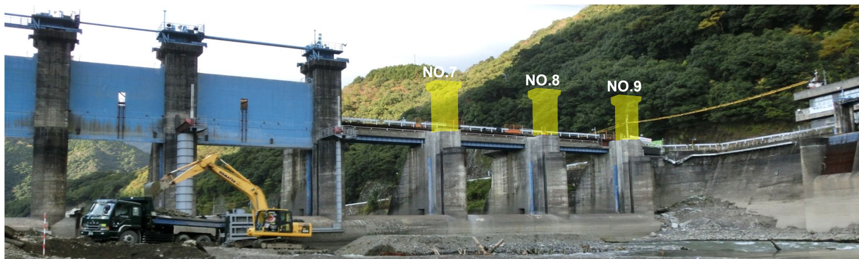
試験施工(コンクリート切断)
