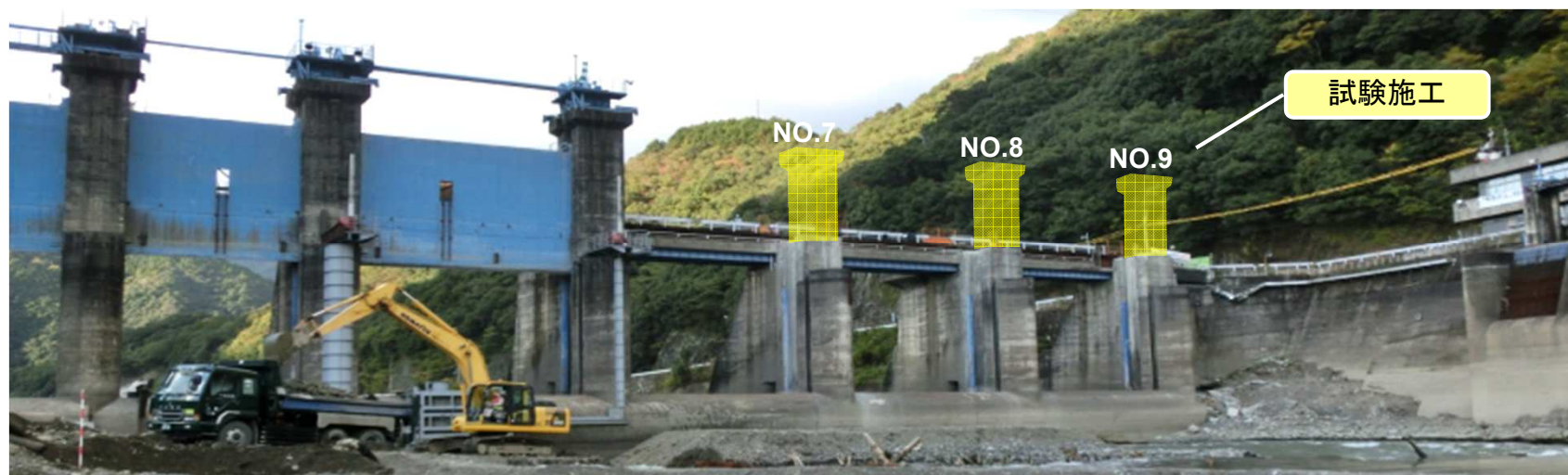
試験施工(コンクリート切断)
