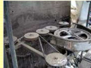
コンクリート切断
