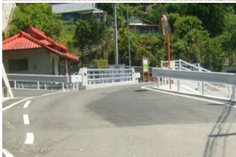
三坂橋嵩上 (H24工事)
