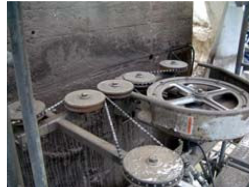
コンクリート切断
