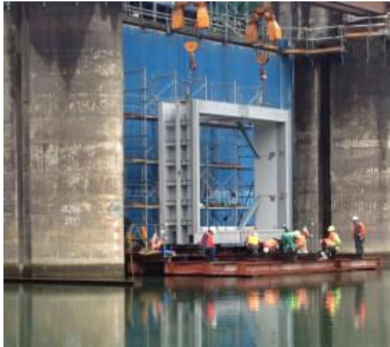
受枠(中間・上流)設置
