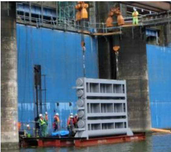
ローラーゲート設置
