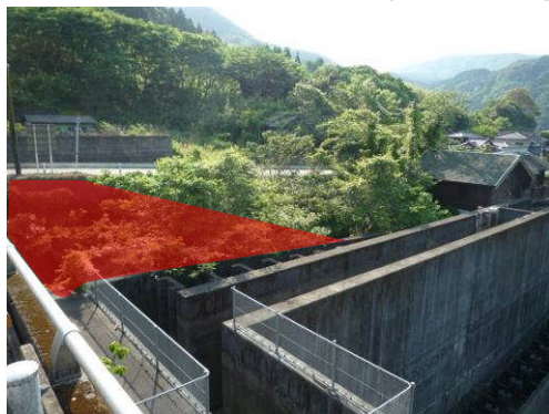
写真: 盛土箇所
