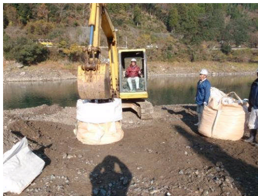
写真:大型土のう製作イメージ
