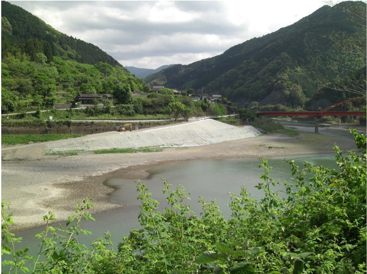
〈葉木橋下流の土砂撤去用仮設道路〉
