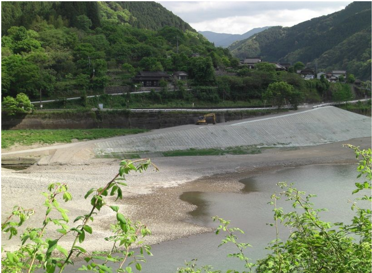
〈葉木橋下流の土砂撤去用仮設道路〉
