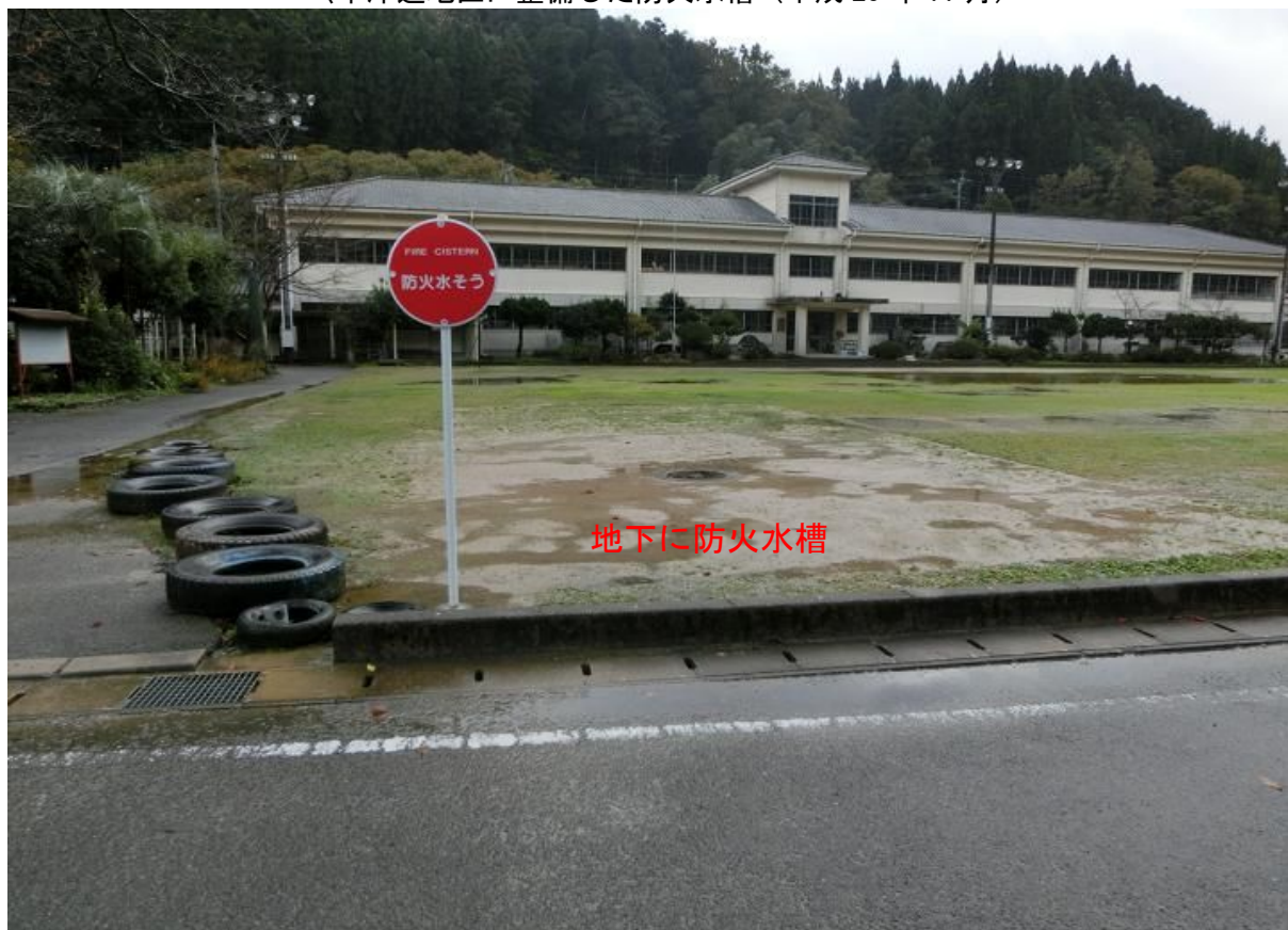
〈中津道地区に整備した防火水槽（平成 25 年 11 月）
