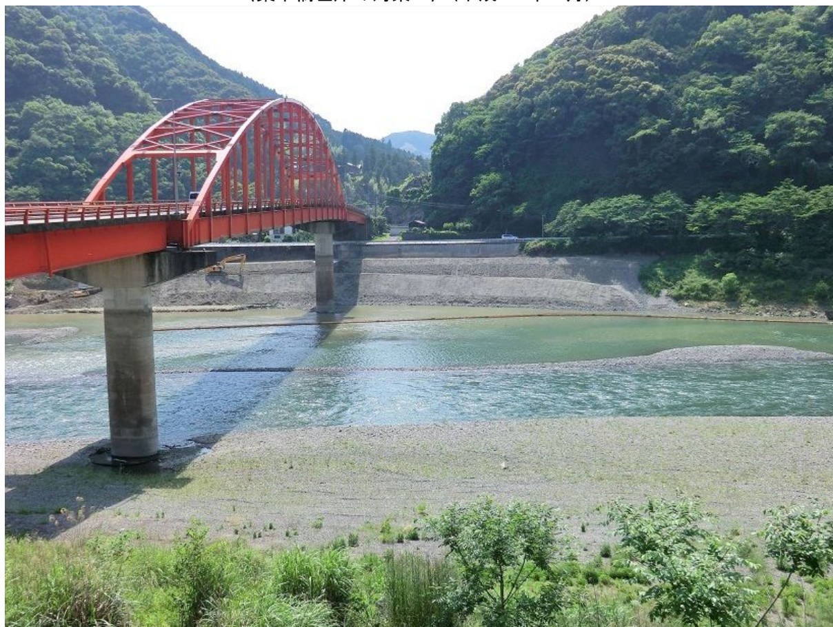
〈葉木橋左岸の対策工〉（平成 26 年 5 月）
