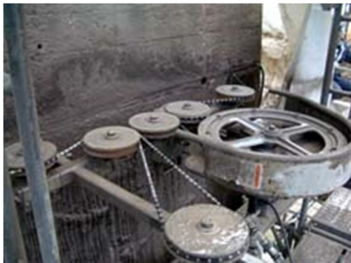
コンクリート切断
