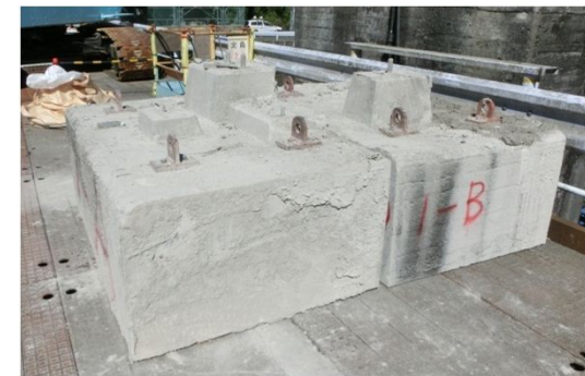
※H25年度施工状況
