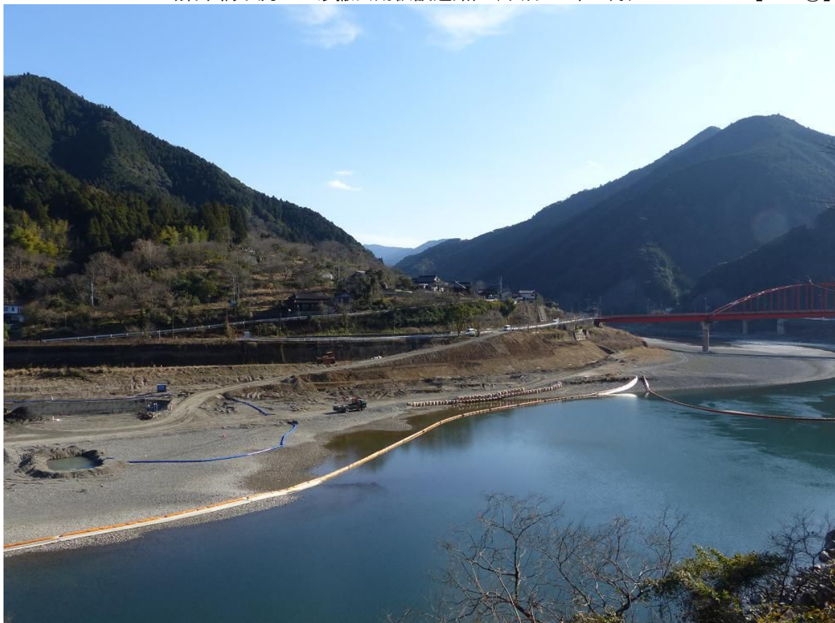
〈葉木橋下流の土砂撤去用仮設道路〉（平成 26 年 1 月）
