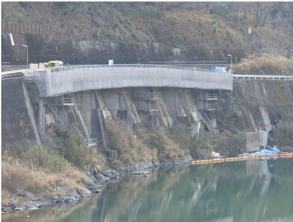
〈藤坂橋の橋梁補修工事〉(平成26年1月)
