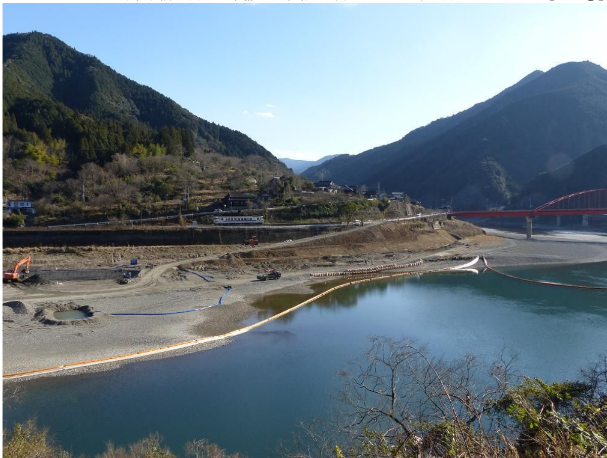
〈葉木橋下流の土砂撤去用仮設道路〉（平成 26 年 1 月）
