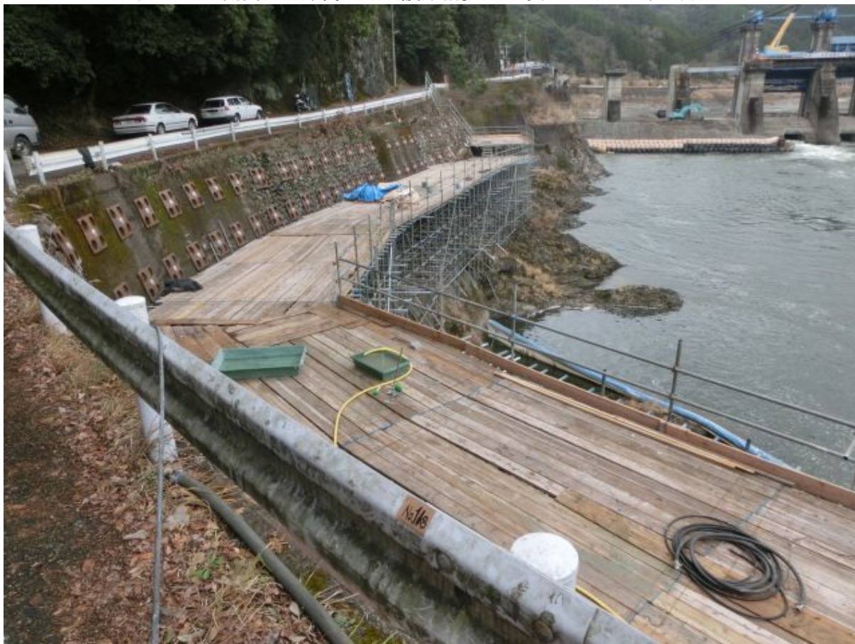
〈ダム～大門間 道路嵩上げ（護岸補強）工事〉（平成 26 年 1 月）
