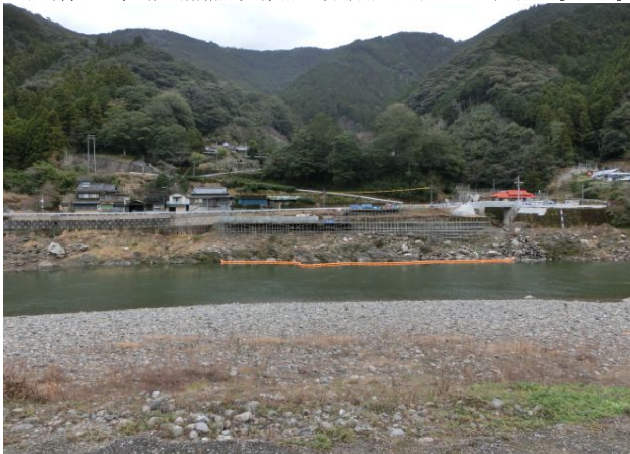
〈道路嵩上げ工事に係る既存階段等の擦り付け予定箇所の近況〉(平成 26 年 1 月) 【A-8.5】
