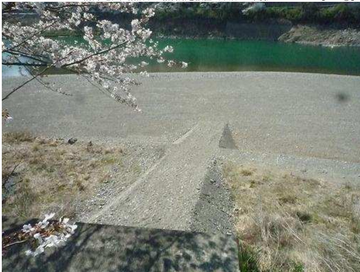
〈葉木地区〉階段下に緩斜路を設置（平成 22 年度）
