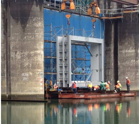
受枠(中間・上流)設置
