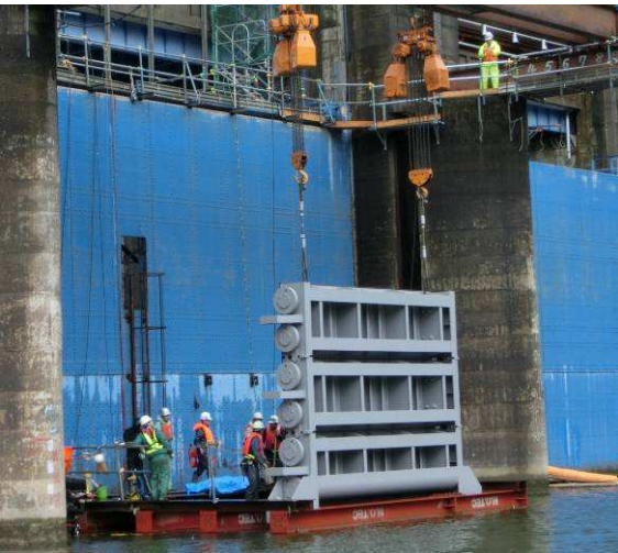
ローラーゲート設置
