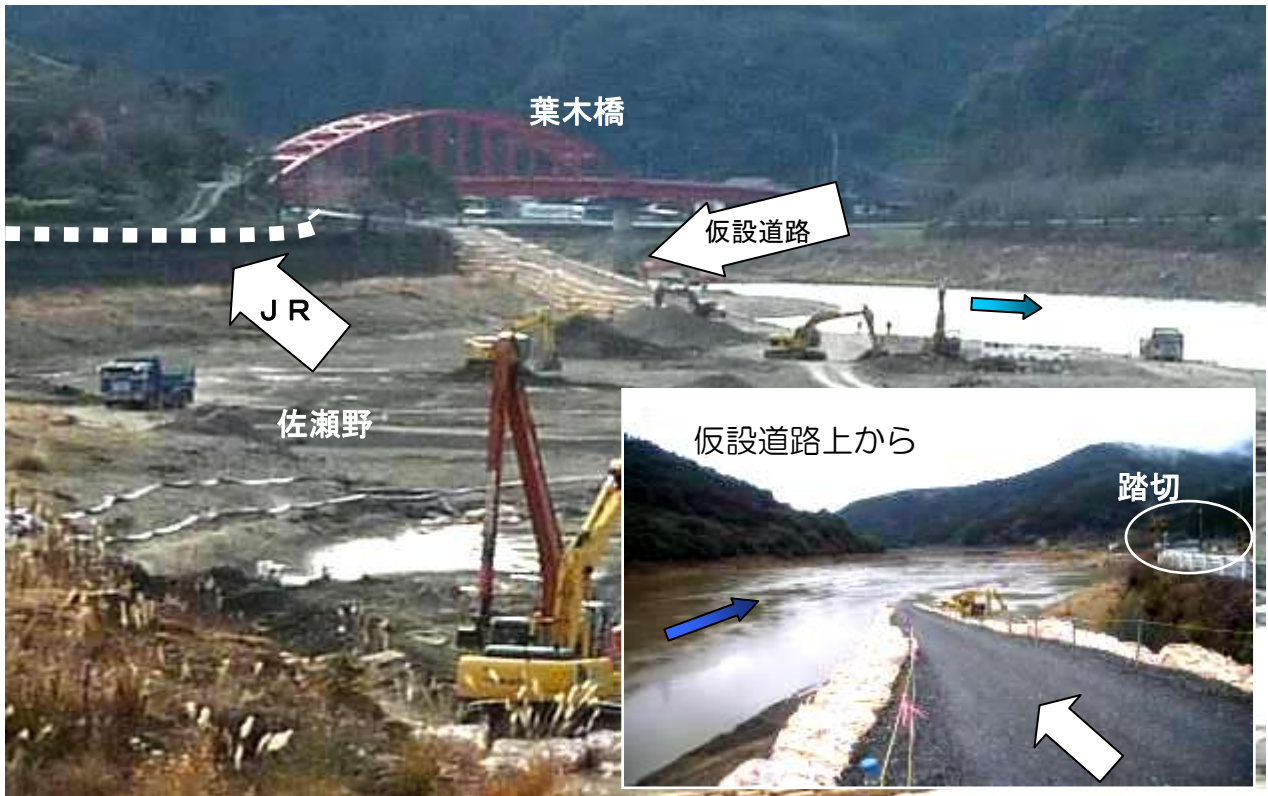
工事用仮設道路 (葉木橋下流) (H23.12.12 八代市意見書提出)
