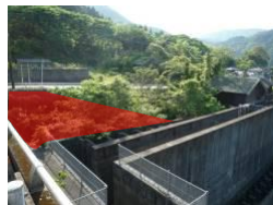
写真：盛土箇所
