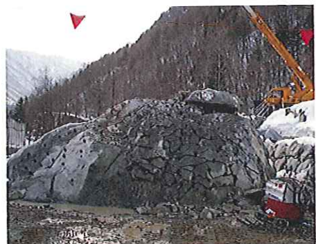
写真：制御発破事例
