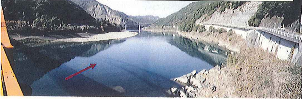
深水橋(ゲート開放前/平成21年12月22日)
