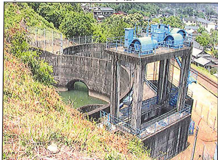
③サージタンク（調圧水槽）
