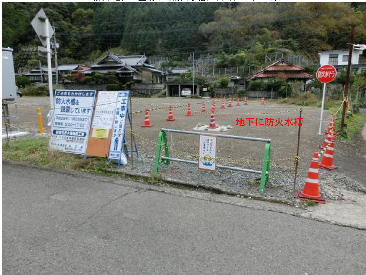
〈葉木地区に整備した防火水槽〉（平成 25 年 11 月）
