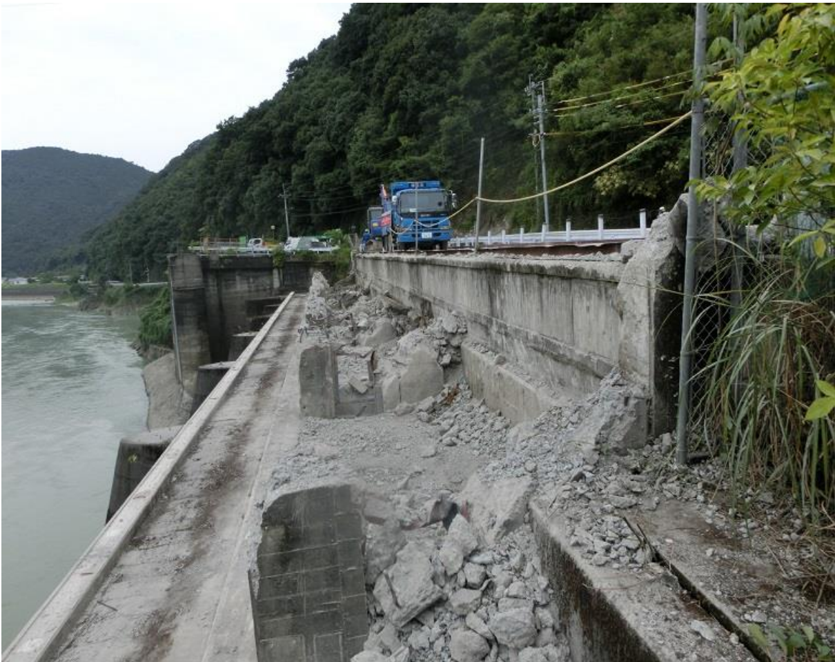
〈取水口の撤去状況〉（平成 29 年 9 月）
