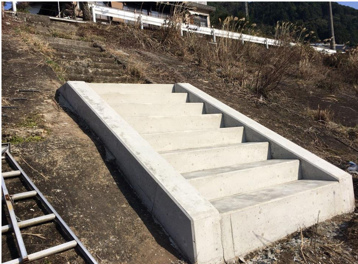
〈葉木地区階段 下流側〉
