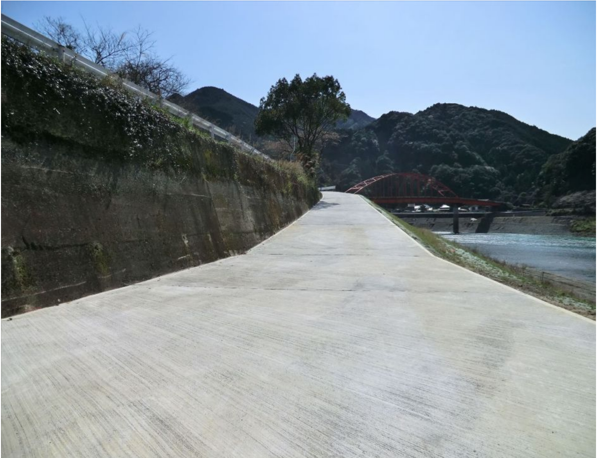
〈葉木橋下流の土砂撤去用仮設道路〉
