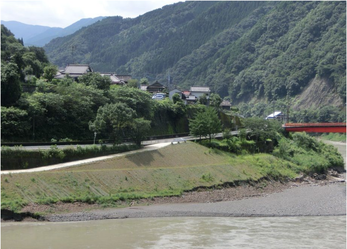
〈葉木橋下流の土砂撤去用仮設道路〉
