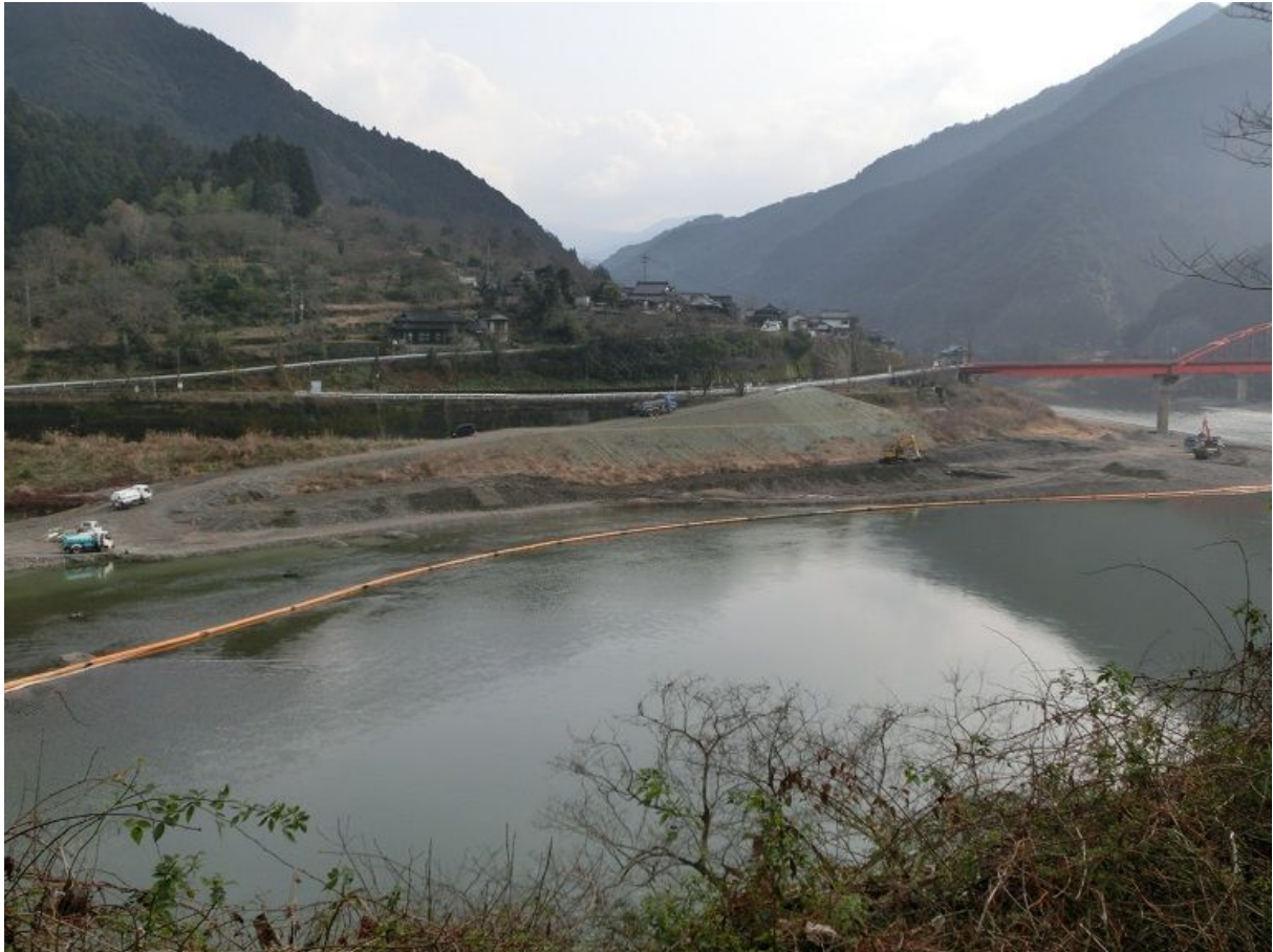
〈葉木橋下流の土砂撤去用仮設道路〉
