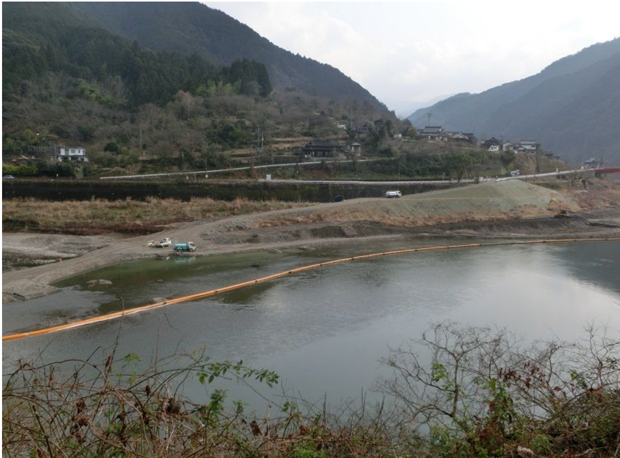
〈葉木橋下流の土砂撤去用仮設道路〉
