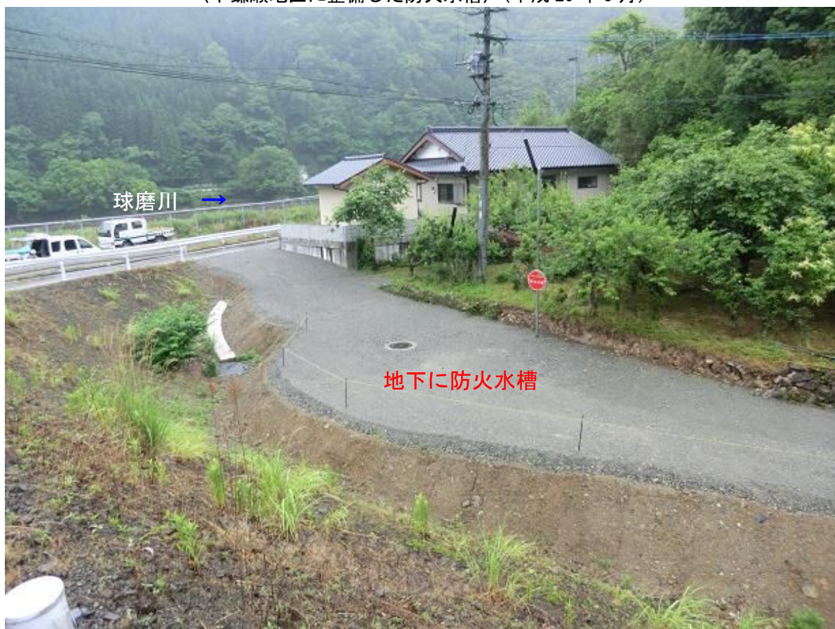
〈下鎌瀬地区に整備した防火水槽〉（平成 25 年 3 月）
