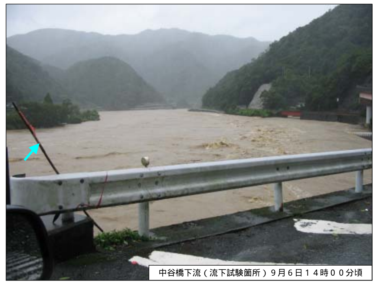
図1-5 出水状況写真
