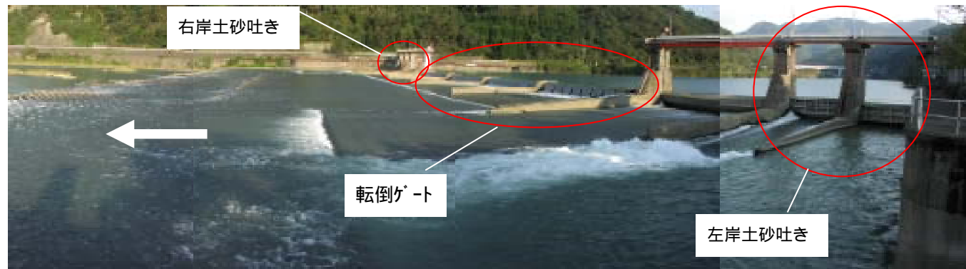
写真 - 2 . 3 遙拝堰取水口の構造
