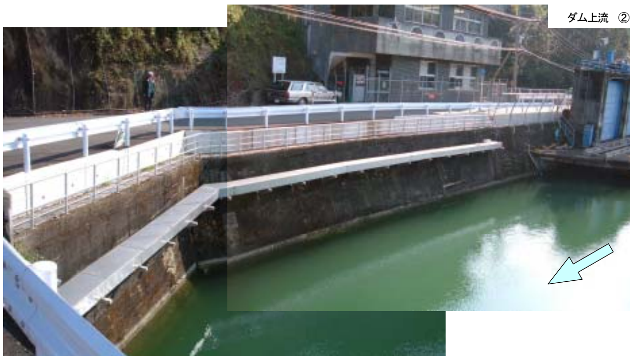
写真2-3 ダム周辺右岸部現況写真(2)
