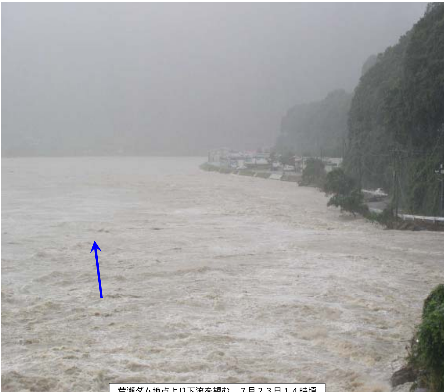
荒瀬ダム地点より下流を望む 7月23日14時頃
