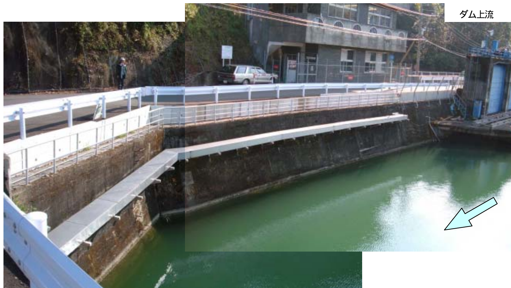
写真3-3 ダム周辺右岸部現況写真(2)
