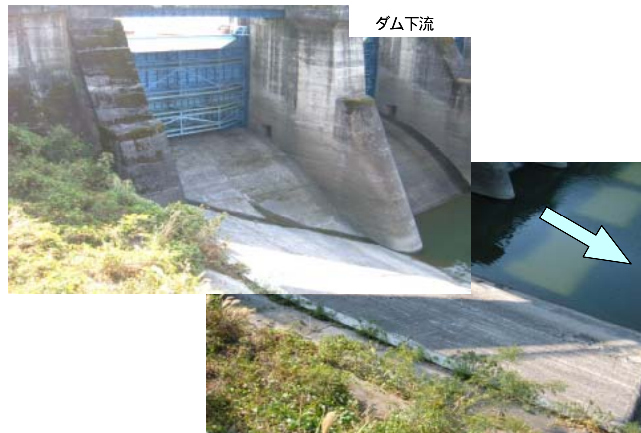
写真3-2 ダム周辺右岸部現況写真(1)
