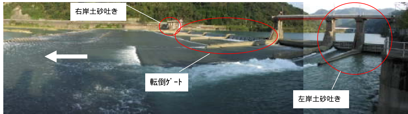
写真 - 1 . 2 . 1 遙拝堰取水口の構造
