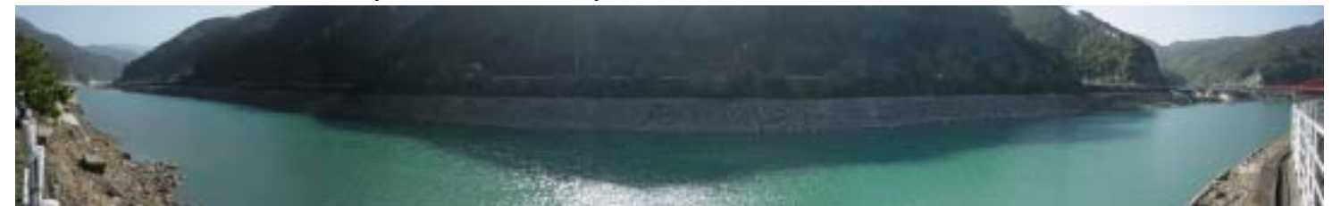
図 2 - 1 4 荒瀬ダムボートハウス付近
