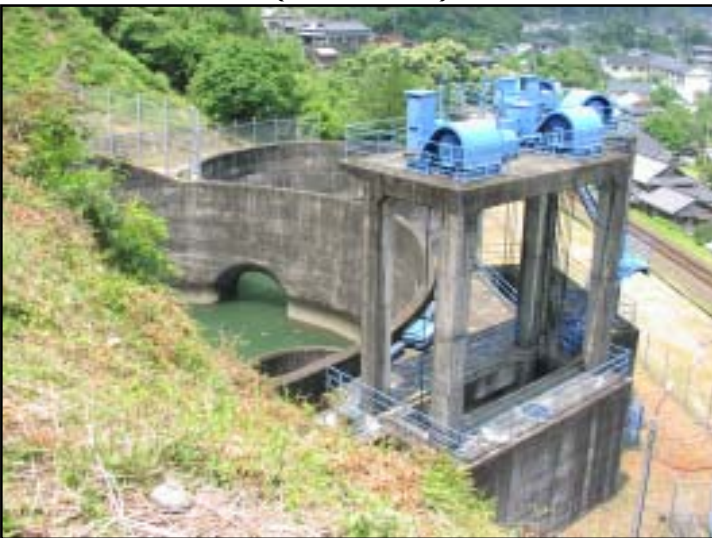
サージタンク（調圧水槽）
