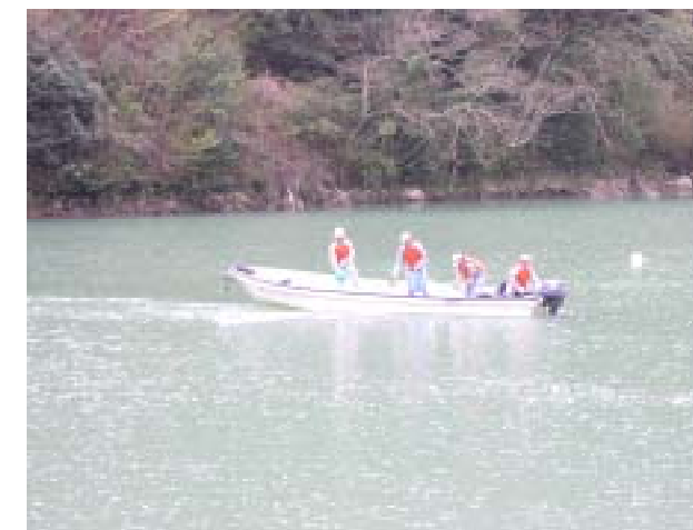
底質改良材投入状況
