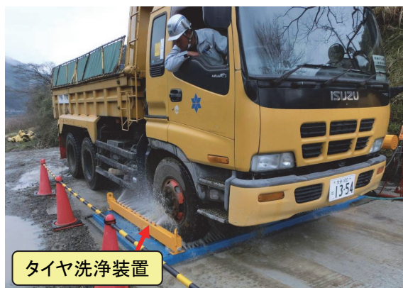
写真- 2.8 タイヤ清掃装置の設置状況
