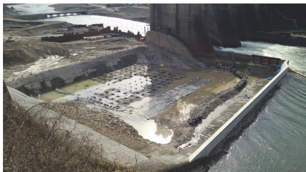
写真- 2.3 下流締切擁壁設置状況
