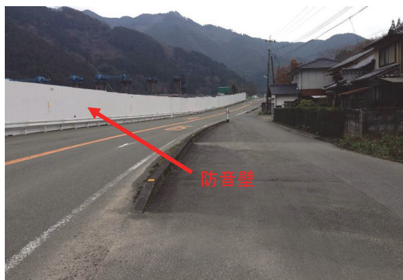
写真- 2.10 防音壁設置状況
