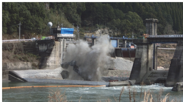
写真- 2.4 堤体みお筋部発破状況
