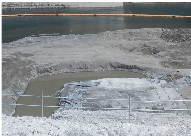
写真- 2.5 盛土設置状況
