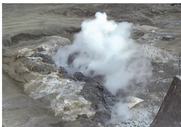
写真- 2.6 左岸越流部発破状況
