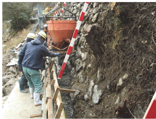
(コンクリート打設)
