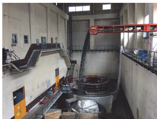
(土砂投入状況)
