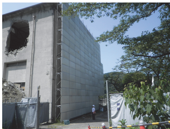
写真- 3.10 防音パネル設置状況
