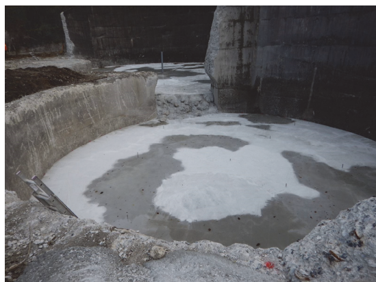
(コンクリート打設完了 (1 層目))
