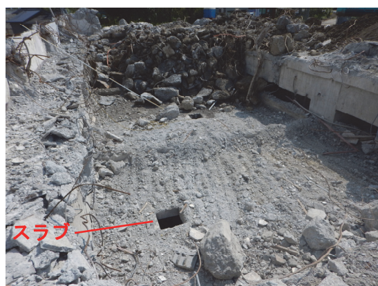
(施工前：キュービクル室)
