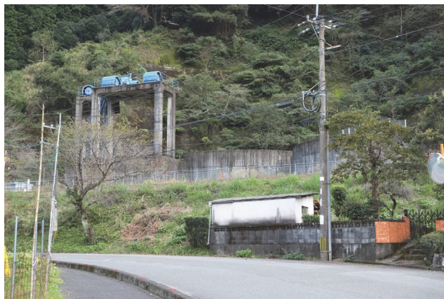
写真- 3.12 着工前状況
