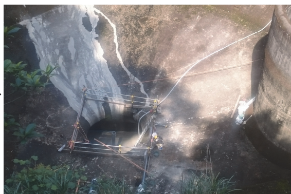
(水槽埋戻し状況)
