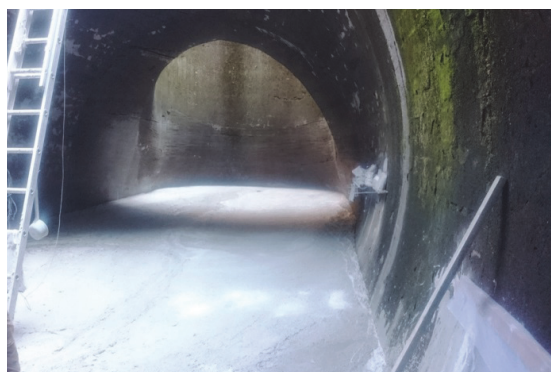
(導水トンネル内埋戻し状況)
