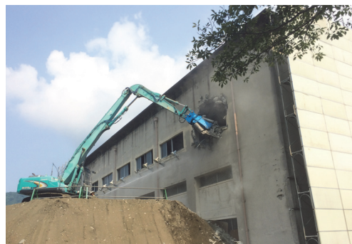
(発電所建屋撤去開始)
