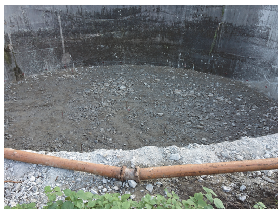
(コンクリート殻埋戻し状況)
