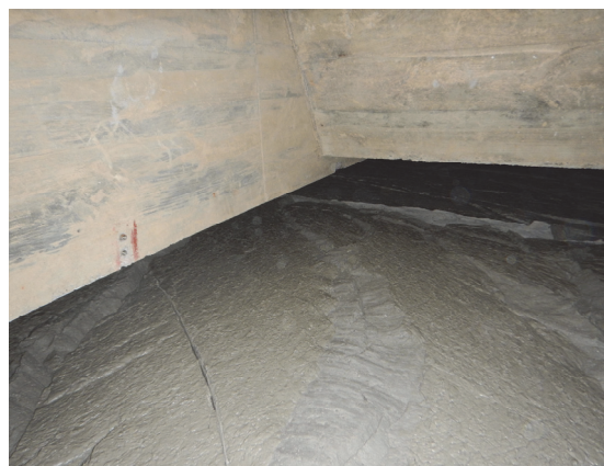
(埋戻し：給排水ポンプ室)
