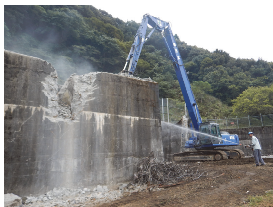
(サージタンク側壁撤去状況)
