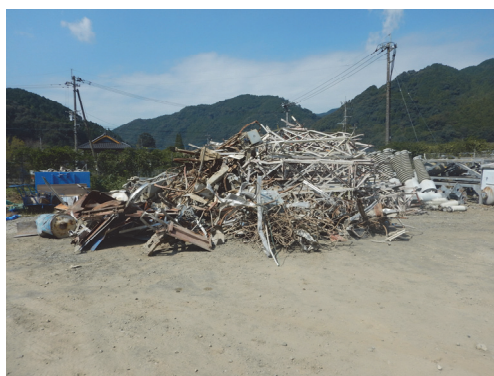
(屋外変電設備撤去完了)
