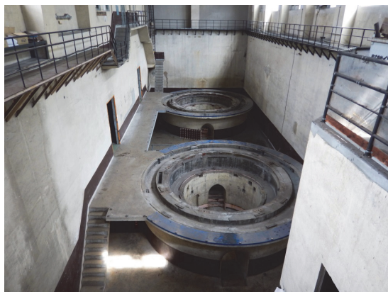
(施工前：水車室)
