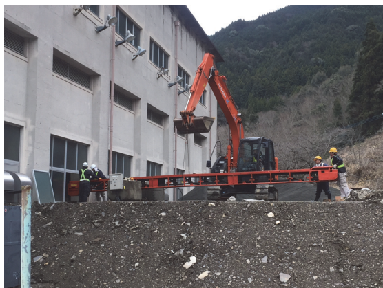
(土砂投入状況)
