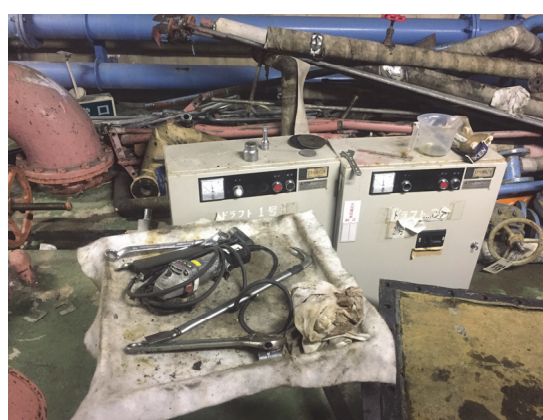
(電気設備撤去)
