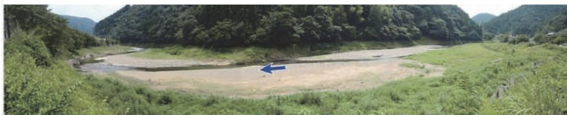
写真- 3.22 ゲート開放後、泥土除去完了後の河川状況（H23.8）
