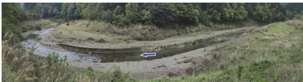
写真- 3.24 ダム撤去完了後の河川状況（H29.5）
