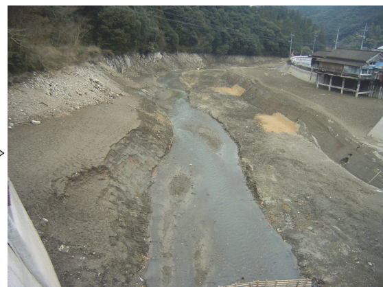
(土砂処理完了)
