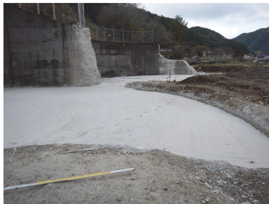
(気泡混合軽量盛土完了)
