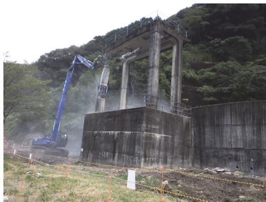
(門柱撤去状況)
