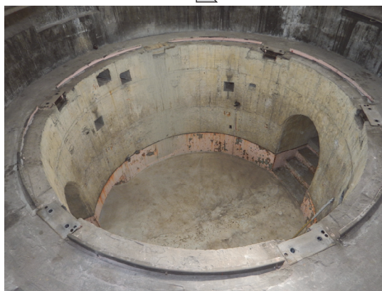
(コンクリート打設完了)
