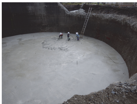
(コンクリート打設状況 (1 層目))
