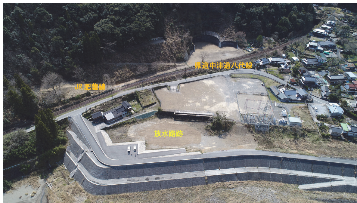
図- 3.22 全体工事完了状況
