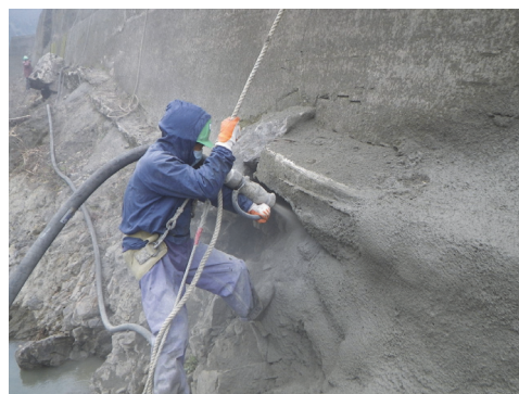
(モルタル吹付)
