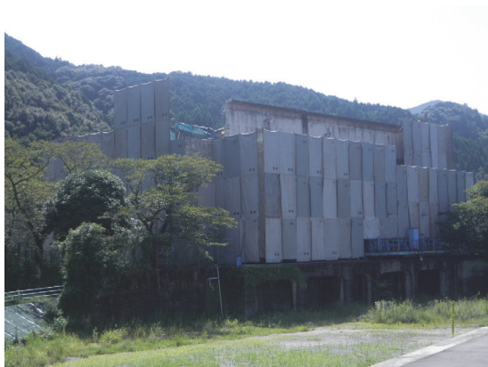
写真- 3.9 養生シート設置状況
