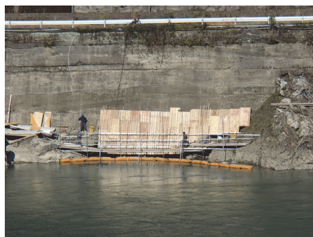
(コンクリート打設)
