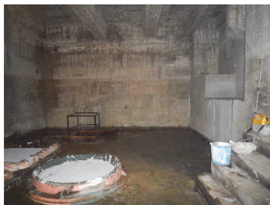
(埋戻し完了：圧油ポンプ室)
