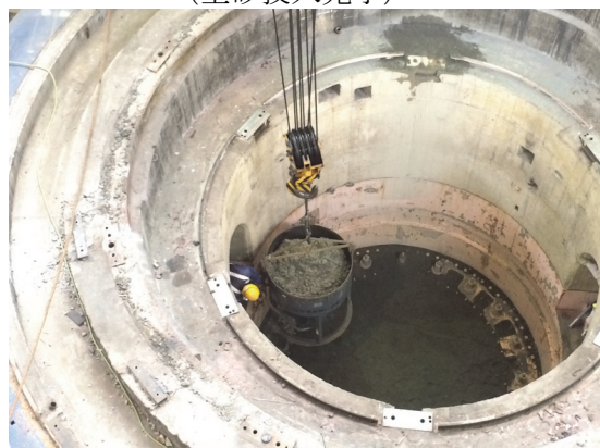
(コンクリート投入状況)
