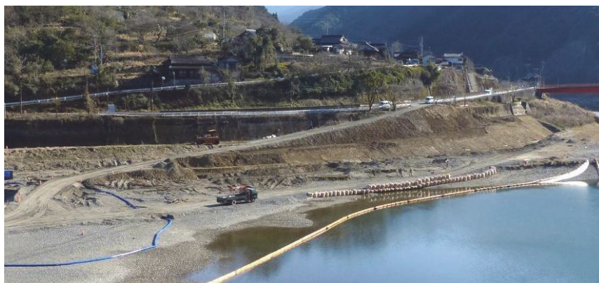
写真- 3.28 工事進入路設置状況
