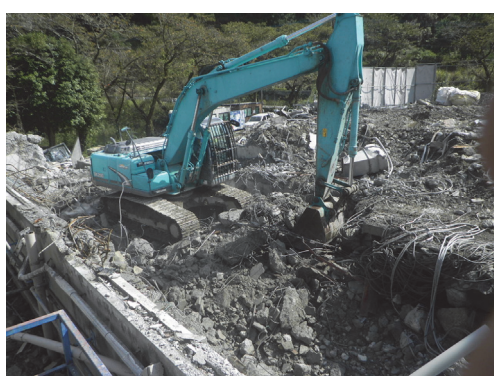
(発電所建屋撤去状況)
