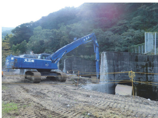
(サージタンク側壁撤去状況)
