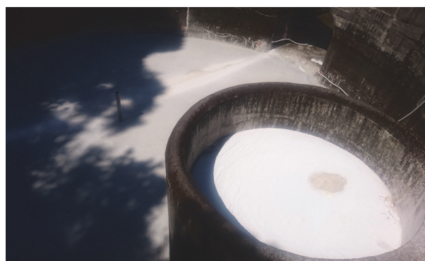
(埋戻し完了：遠景)
