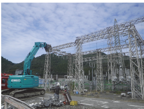
(屋外変電設備撤去前)
