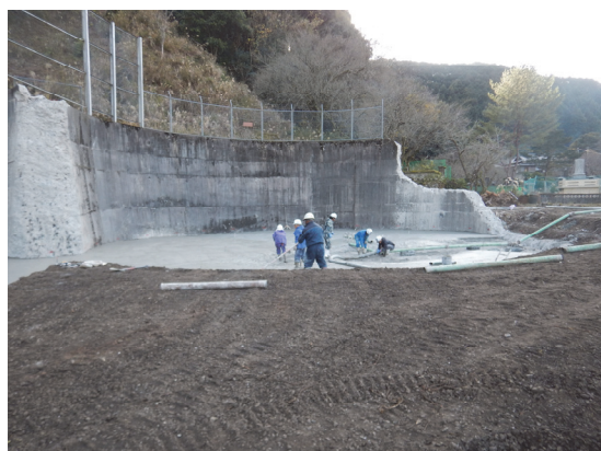
(コンクリート打設状況 (2 層目))
