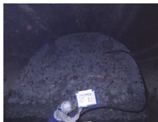
(ラス張り完了)
