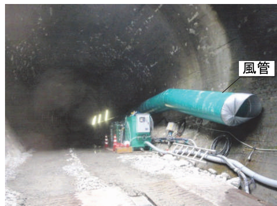
写真- 2.207 換気設備設置 (下流側)
