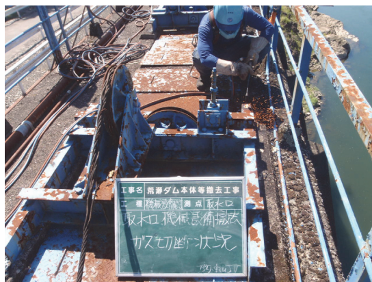
(巻上機架台切断)
