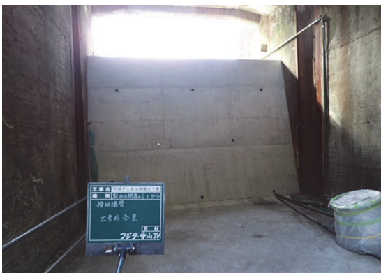
(コンクリート打設完了)
