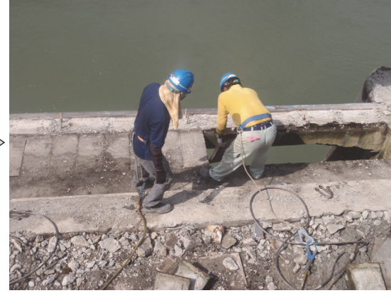
(除塵機スラブ撤去)
