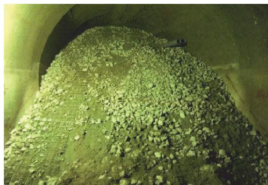
(導水管路上流端埋戻し完了：サージタンク側)
