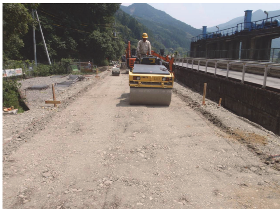
(敷均し・転圧)
