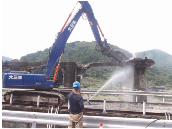
(巻上機架台撤去)
