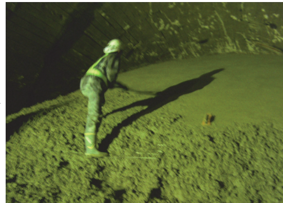
(コンクリート打設)
