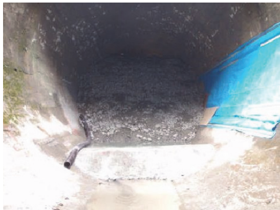
(下流端完了：サージタンク側)
