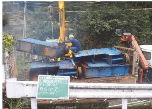
(ゲート吊り上げ・積込)
