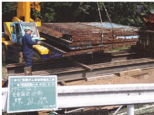
(スクリーン吊り上げ・積込)
