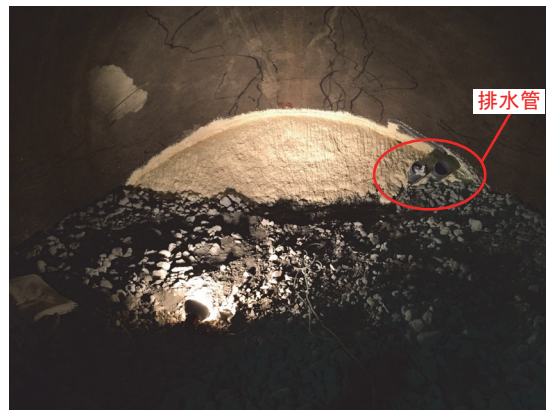
写真- 2.214 排水管設置状況（No.1 下流側）
