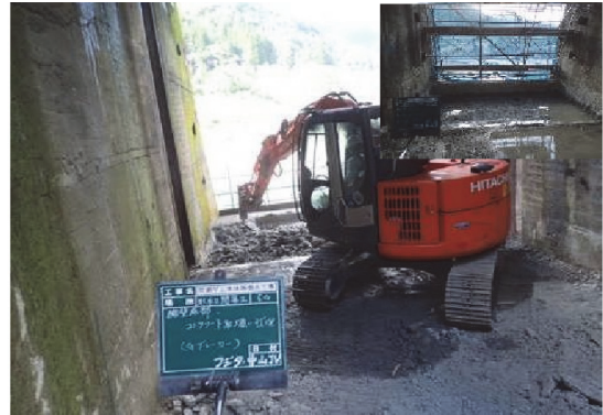
(底版コンクリート撤去)
