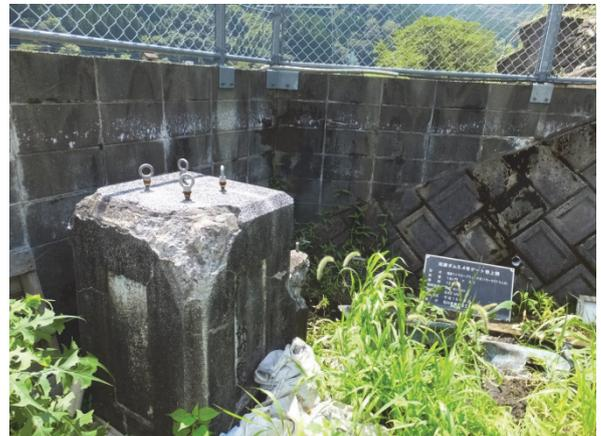
(親柱 (下流側: 補修・移設設置))
