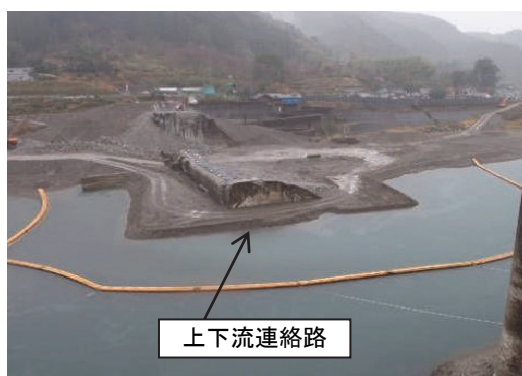
写真- 2.157 仮設道路及び施工ヤードの設置状況
