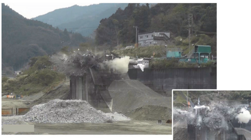
写真-2.163 非越流部の発破状況
