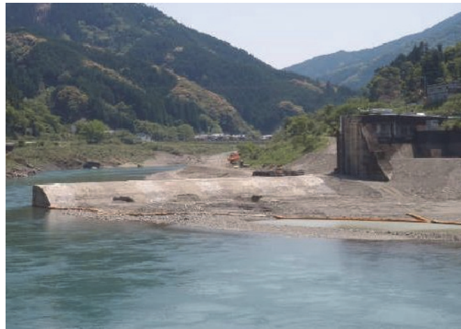
写真- 2.151 門柱下流残存部の撤去完了状況
