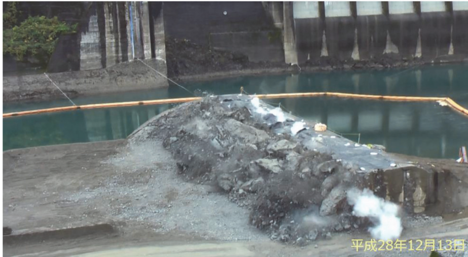
写真- 2.159 越流部（上部②）の制御発破状況
