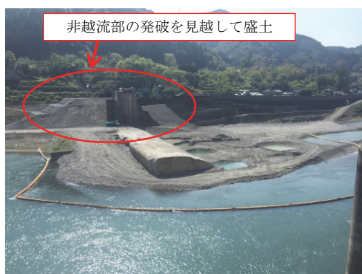
写真- 2.152 門柱残存部撤去完了時の状況
