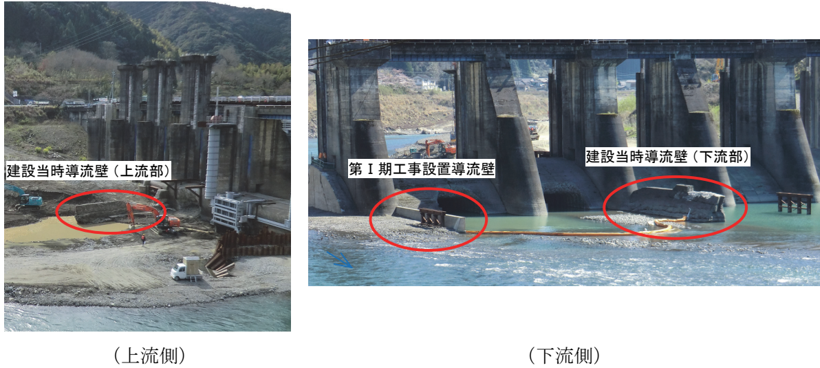
写真- 2.164 残存物の撤去前の状況
