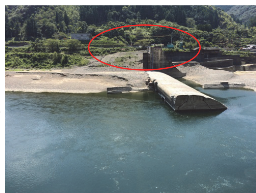
写真- 2.153 出水後の状況
