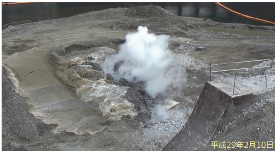
写真- 2.160 越流部（下部④）の制御発破状況
