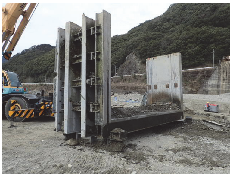
写真- 2.169 仮締切設備下部の撤去完了状況
