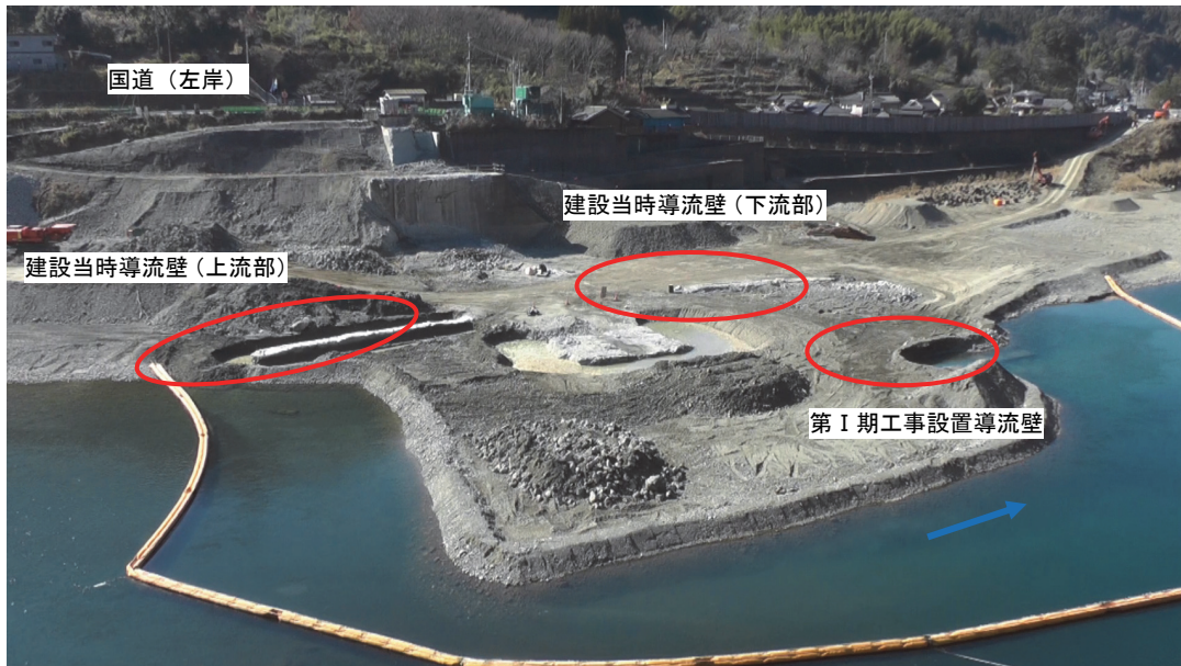
写真- 2.165 残存物の撤去時の状況
