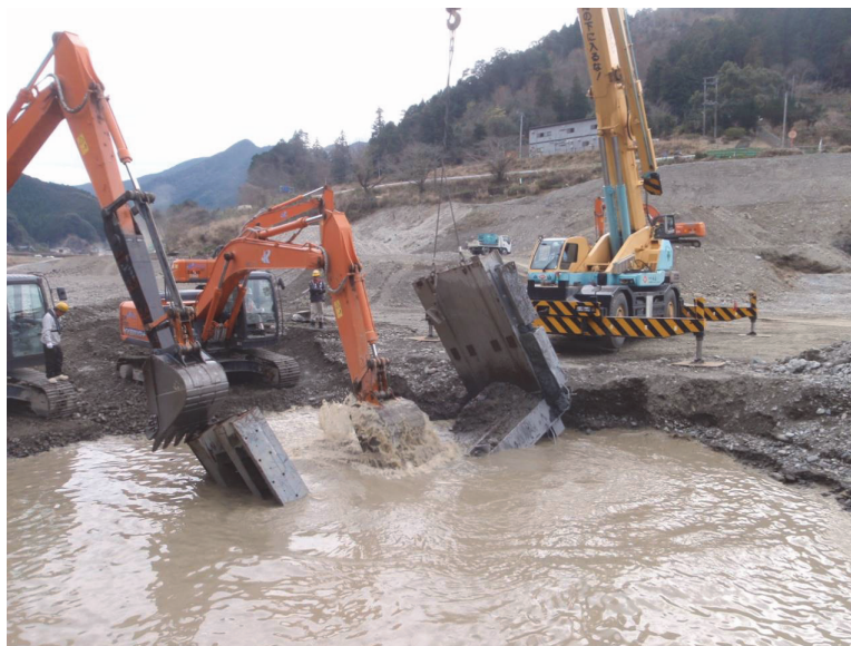
写真- 2.168 仮締切設備下部の引上げ状況
