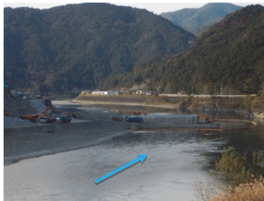
写真- 2.155 施工ヤード造成状況
