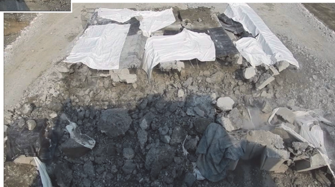
写真- 2.145 門柱倒壊後の小割発破及び残存部発破の状況 (P2)
