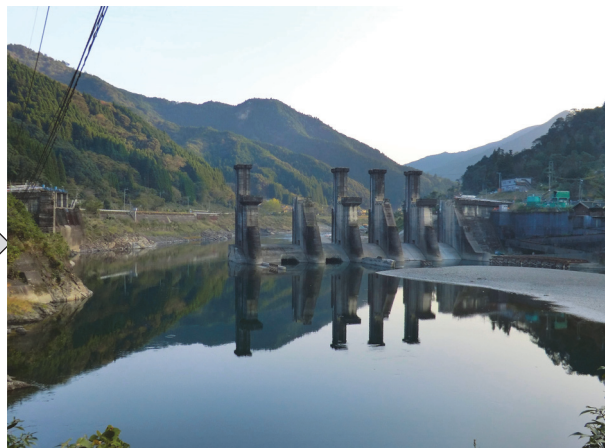
(管理橋撤去完了)
