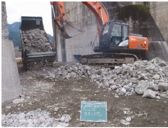
(コンクリート殻敷設状況)
