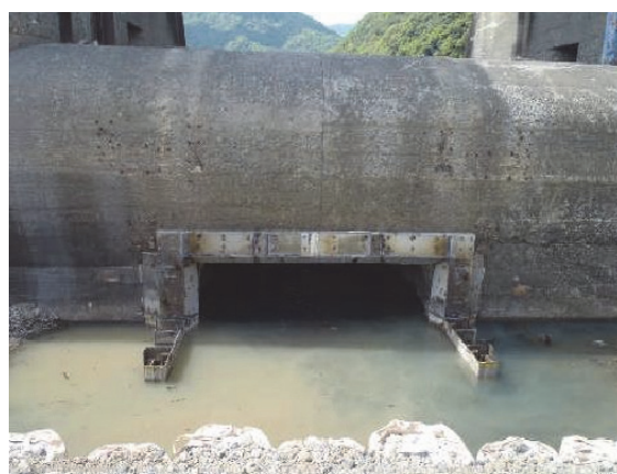
(撤去完了：関連設備 (上部のみ))
