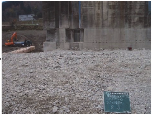
(コンクリート殻敷設完了)
