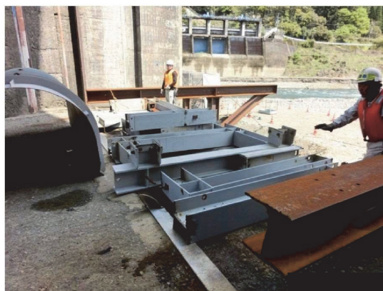
(関連設備分解 (上部のみ))
