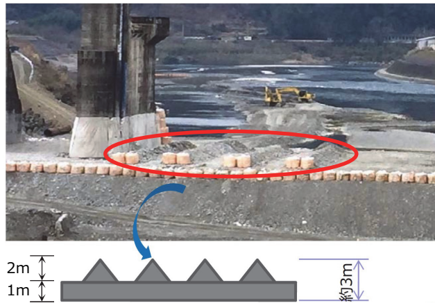
図- 2.96 コンクリート殻（クッション材）の配置（P4）
