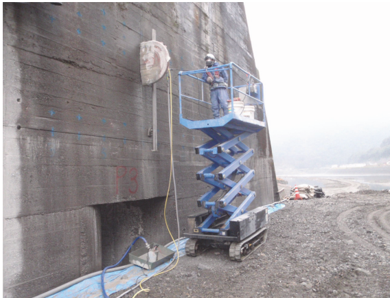
(鉄筋 (横筋) 切断 : ウォールソー)
