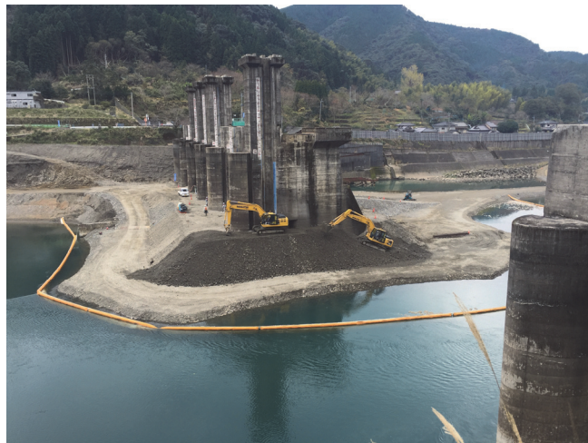
写真- 2.138 施工ヤード及び上下流連絡路の造成状況
