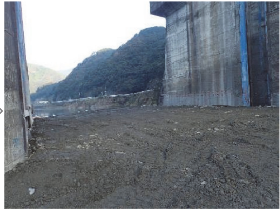
(土砂敷設完成)
