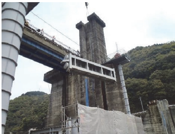
(ゲート扉体分解・搬出)
