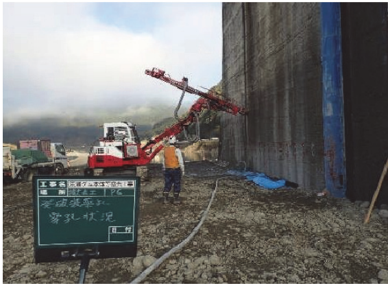
(削 孔 (上方より))
