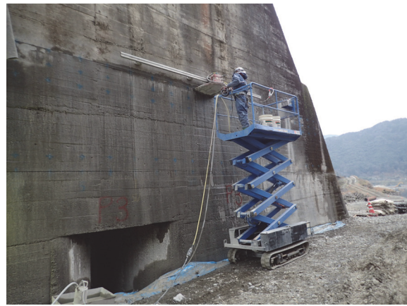
(鉄筋 (縦筋) 切断 : ウォールソー)
