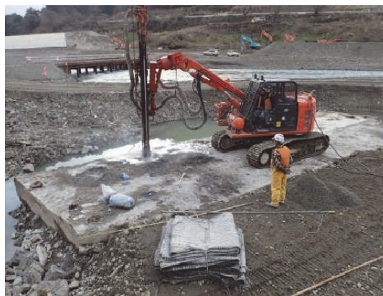
（発破削孔状況）
