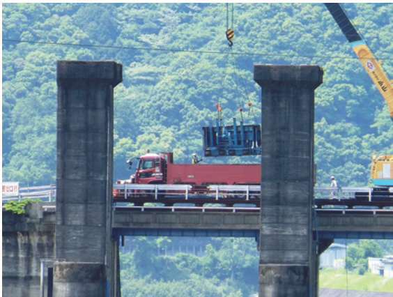
(吊出し・積込・運搬)
