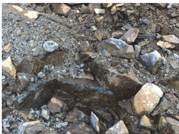
写真- 2.111 コンクリート撤去後の岩盤
