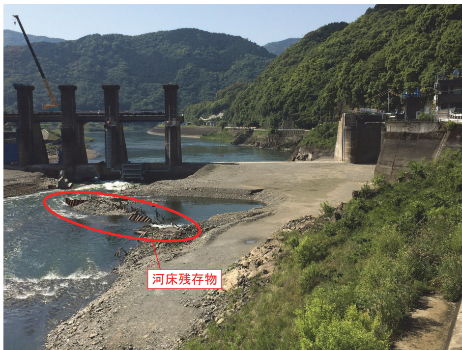
写真- 2.113 建設当時の河床残存物の状況
