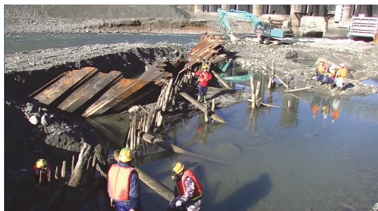
写真- 2.124 「土木学会」による牛柁採取状況
