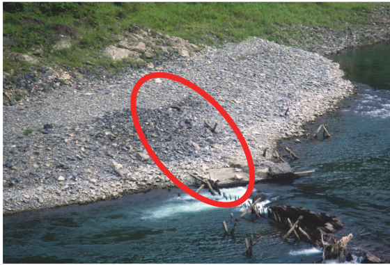
写真- 2.121 締切コンクリートの残存状況
