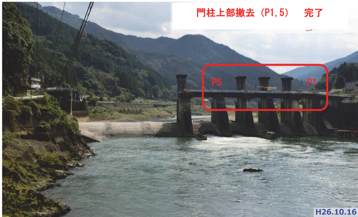
写真- 2.95 門柱上部の撤去完了状況
