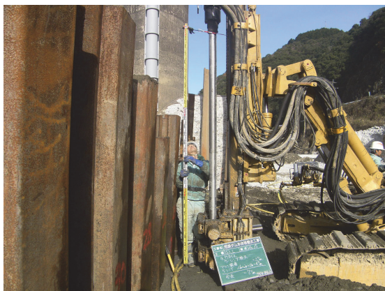
(注入孔削孔)
