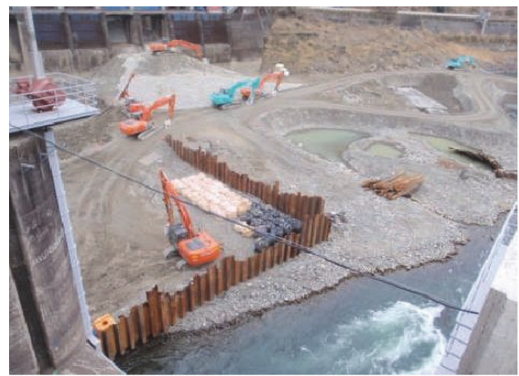
(鋼矢板の打設完了)
