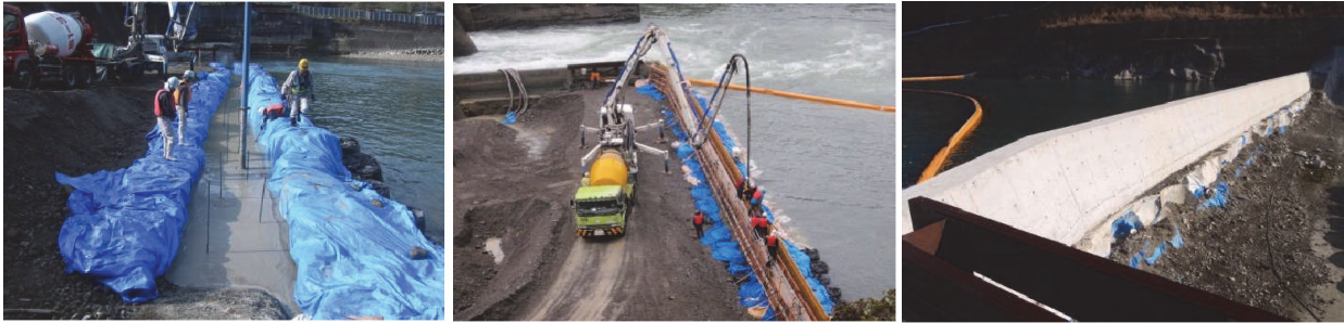
(水中コンクリート打設)
