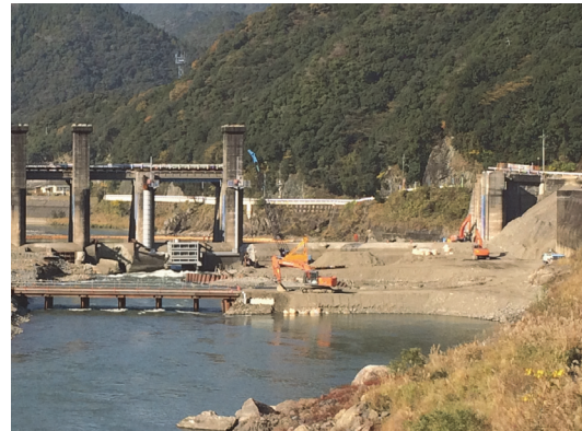
(施工ヤード完成)
