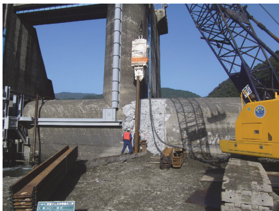
(鋼矢板の打設)
