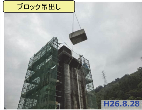
(ブロック吊出し)
