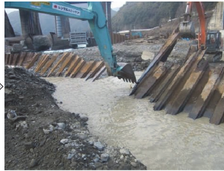
(引き抜き状況)
