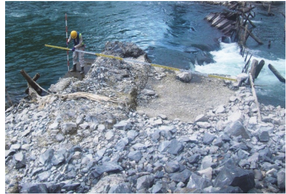
写真- 2.121 締切コンクリートの残存状況
