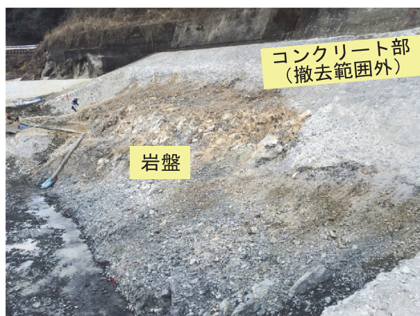
写真- 2.112 コンクリートと岩盤 (水叩き右岸部)
