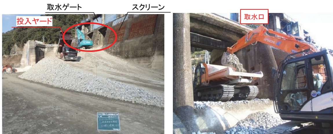
写真- 2.100 投入ヤードへの運搬状況
