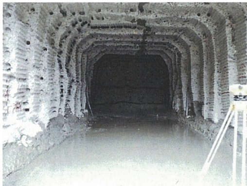
写真- 2.13 工事の中断状況（左岸側）
