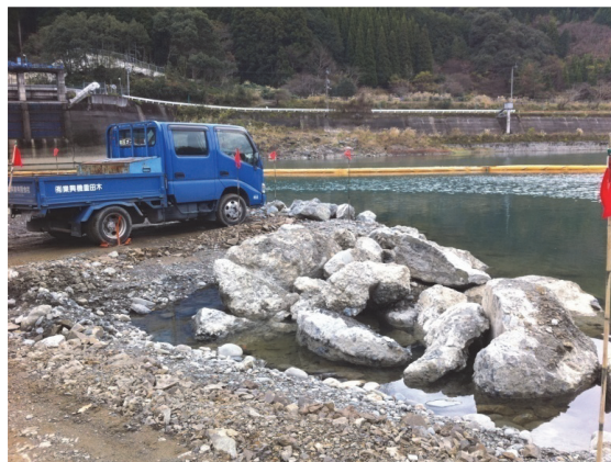
写真- 2.22 除去したコンクリート塊
