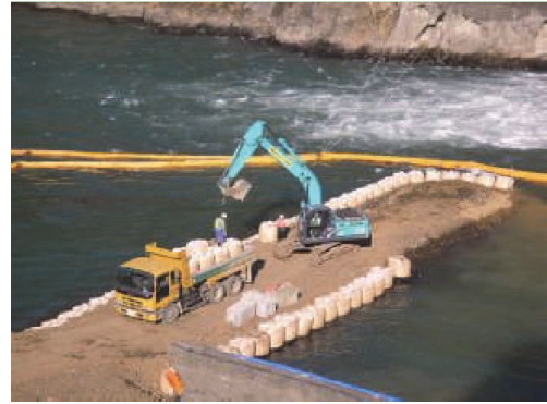
(施工状況①)
