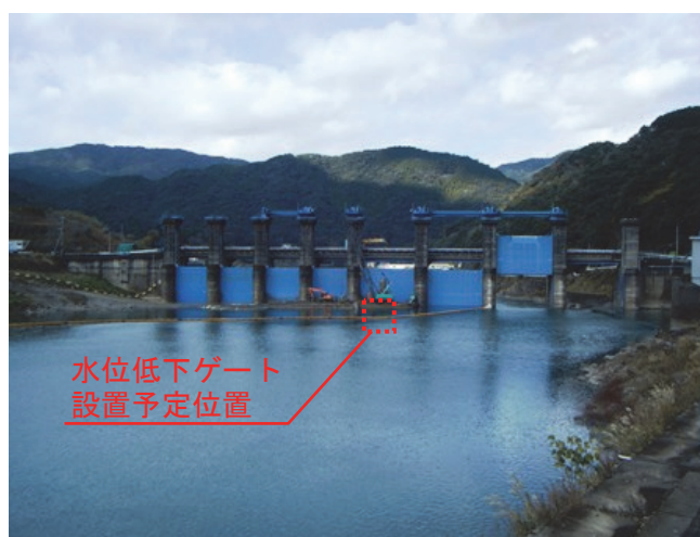
写真-2.18 水位低下ゲート設置前の状況
