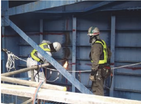
(ゲート荒切り状況)
