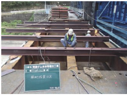
(拡幅材設置)
