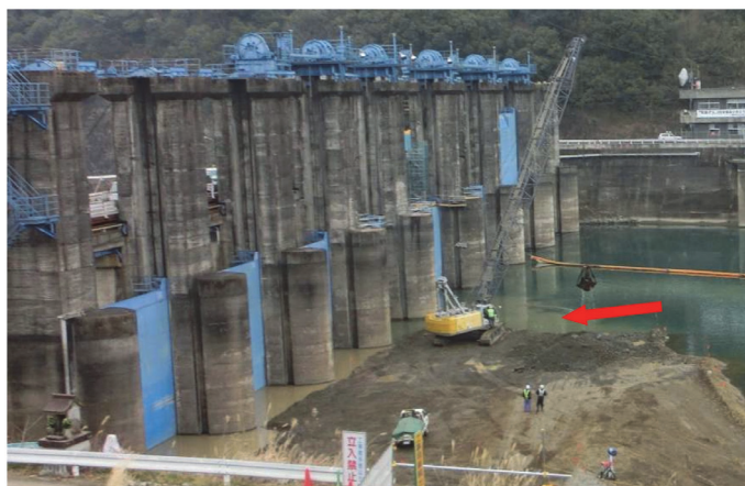
写真- 2.24 堆積土砂の掘削状況
