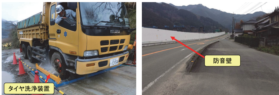
写真- 2.40 タイヤ洗浄装置設置及び防音壁の設置
