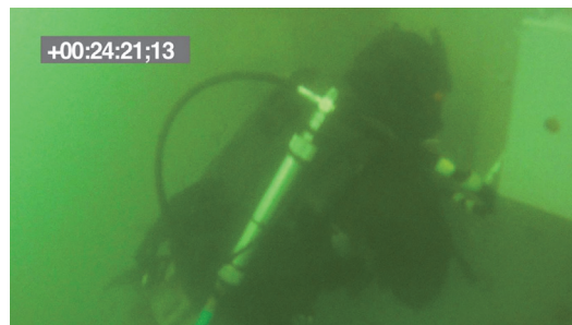
写真- 2.29 水中作業の状況
