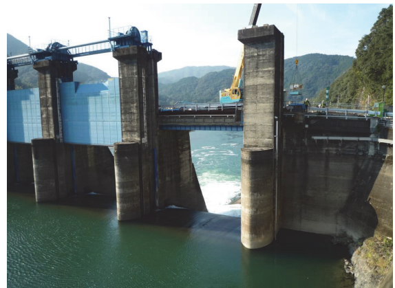
(8号ゲート撤去完了)
