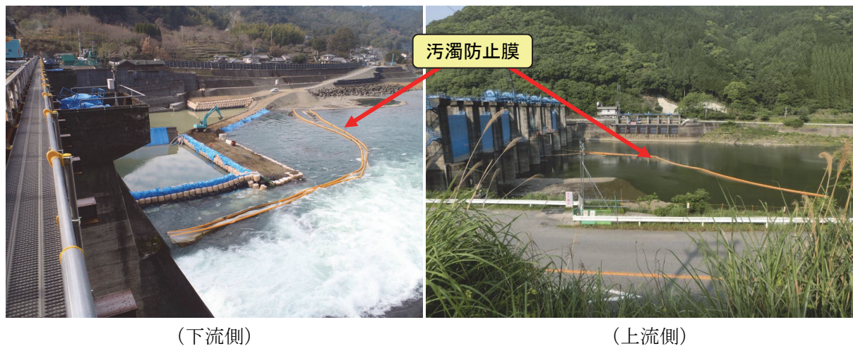
写真- 2.39 汚濁防止膜の設置
