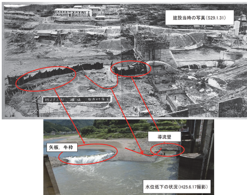
写真- 2.34 建設当時と現状の比較
