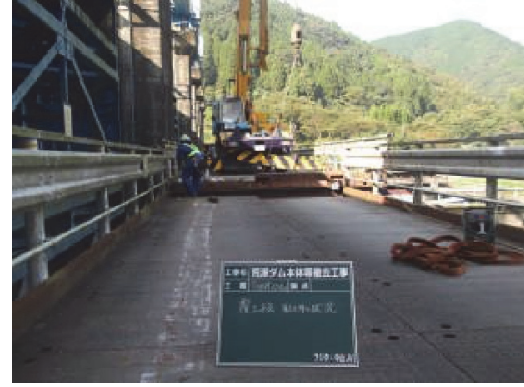
(既設覆工板等撤去)
