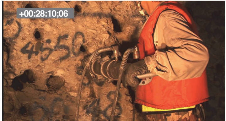
写真- 2.12 貫通時の人力施工の状況（右岸側）
