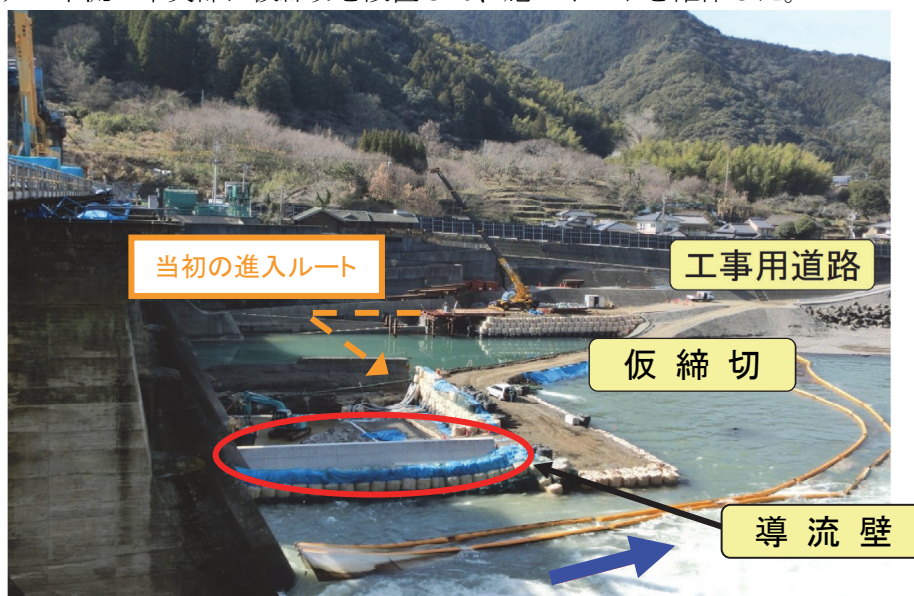
写真- 2.3 工事用道路及び仮締切の施工
