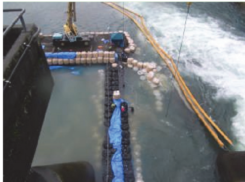
(施工状況②)
