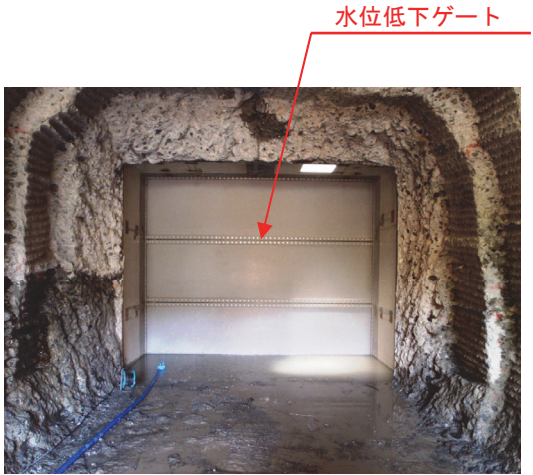
写真- 2.11 放流工の貫通状況（右岸側）
