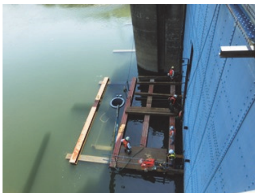
写真- 2.30 水位低下ゲート設置後の全景
