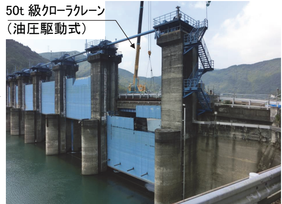
(ゲート切断・吊上状況)
