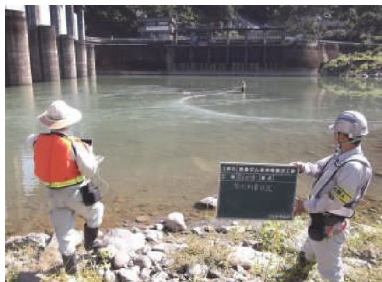
写真- 2.16 深淺測量の状況 (ラジコンボート使用)
