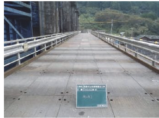
(覆工板等設置：完了)
