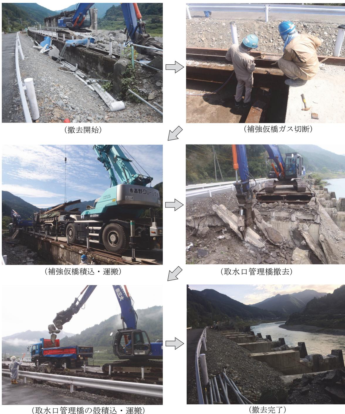
写真- 2.231 補強仮橋及び取水口管理橋の撤去状況
