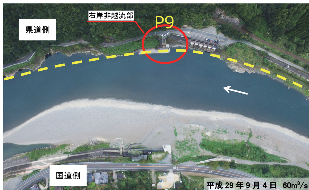
写真- 1.3 ダムの現況（上空から）
