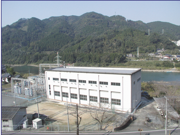
写真- 3.1 藤本発電所の状況
