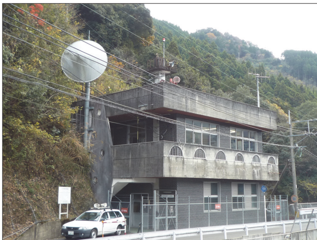
写真- 3.3 ダム管理所の状況
