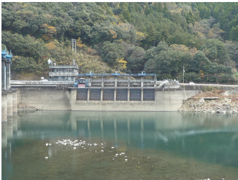
写真- 2.3 ダムサイト上流右岸の状況
