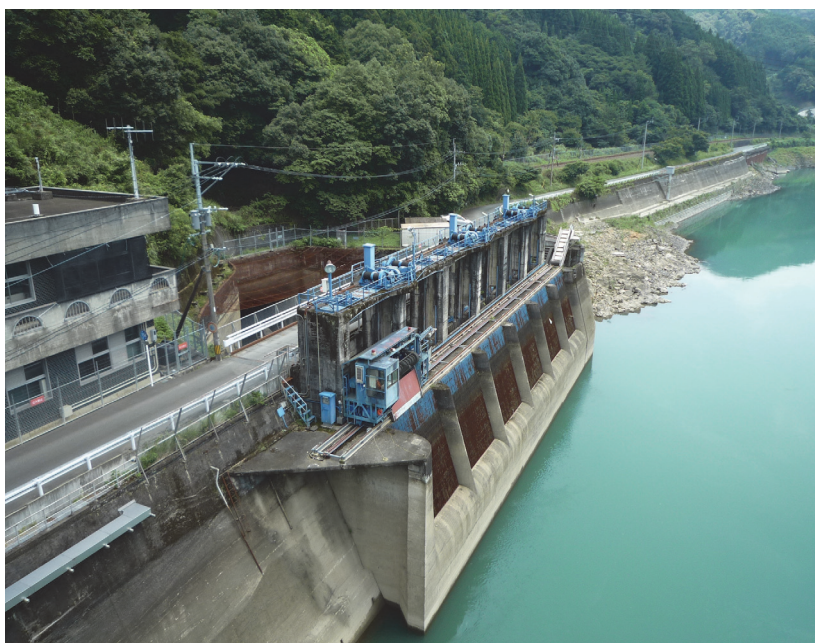
写真- 2.4 取水施設付近の状況
