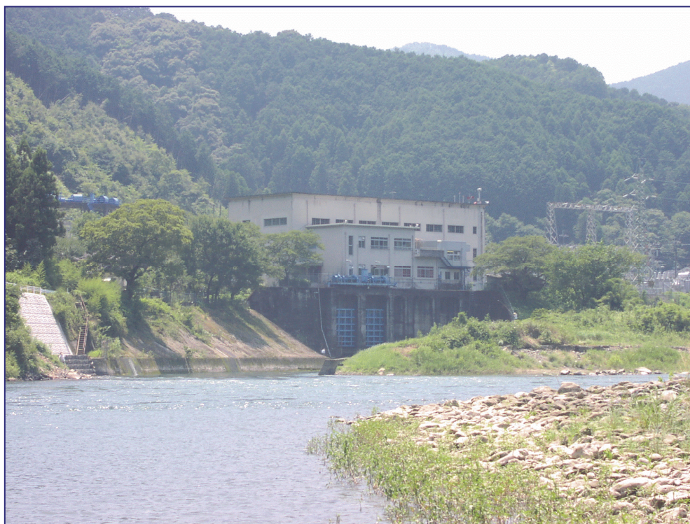
写真- 2.1 荒瀬ダム放水路
