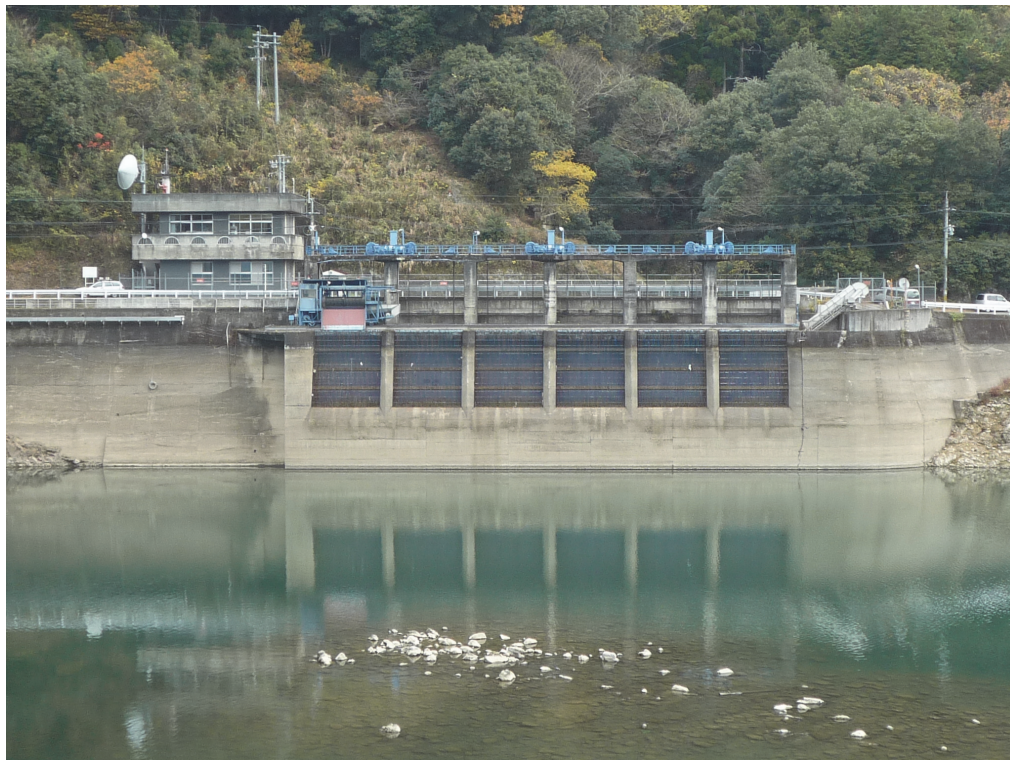
写真- 2.2 荒瀬ダム取水施設の状況
