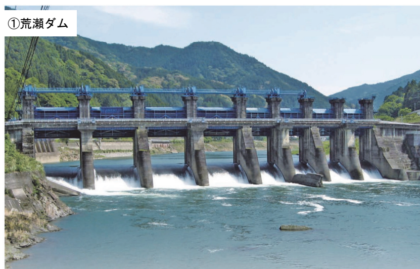
写真- 2.2 撤去前の荒瀬ダム
