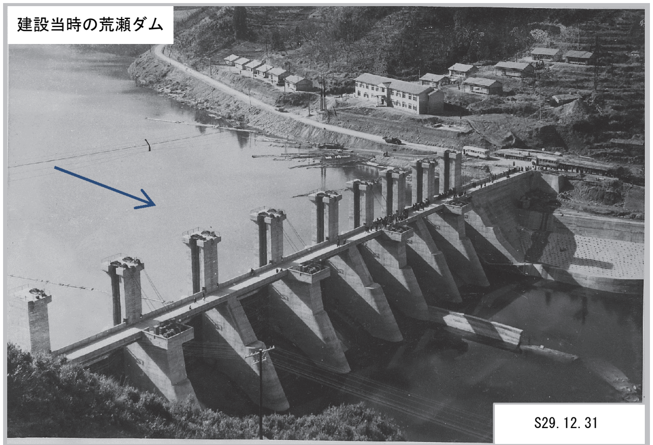
写真- 1.2 建設当時の荒瀬ダム (完成後)
