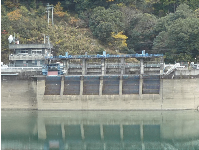
取水設備撤去着手前（平成 22 年）
