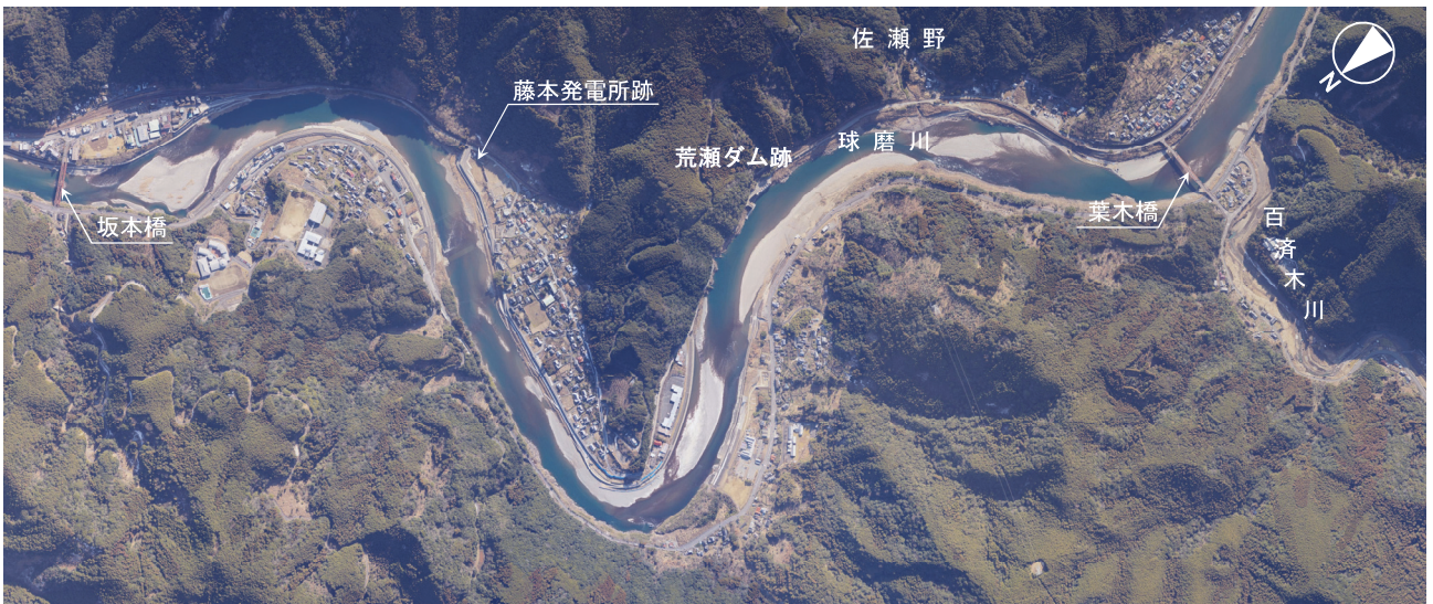
荒瀬ダム撤去完了後全景（平成 30 年）
