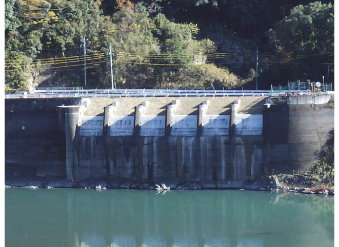
取水設備撤去完了後（平成 29 年）
