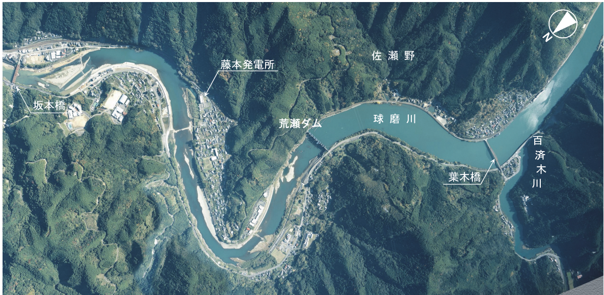
荒瀬ダム撤去着手前全景（平成 21 年）
