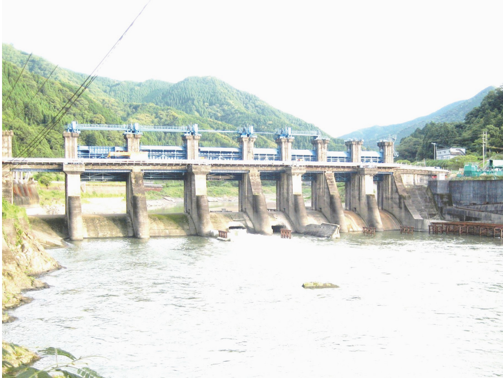
平成24年度（第Ⅰ期）撤去完了
