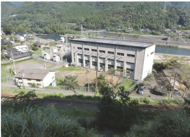
発電所撤去着手前（平成 29 年）
