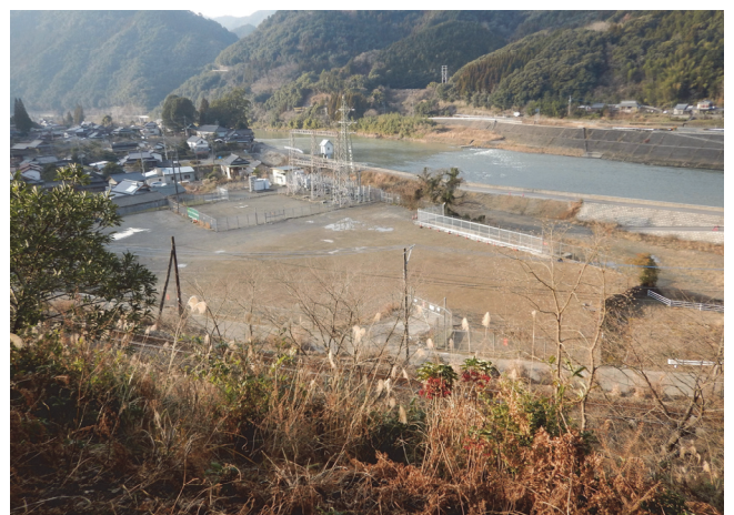
発電所撤去完了後（平成 29 年）
