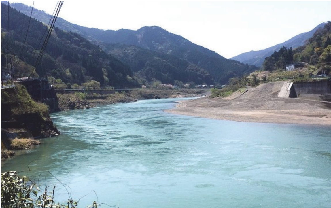
荒瀬ダム撤去完了後（平成 30 年：右岸下流より）
