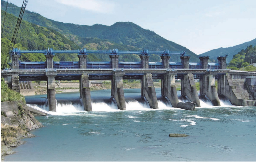
荒瀬ダム撤去着手前（平成 24 年：右岸下流より）
