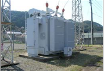
主要変圧器 外形図・状況写真
