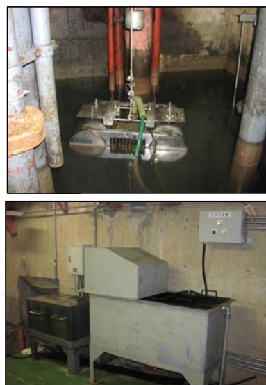
油水分離器 外形図・状況写真
