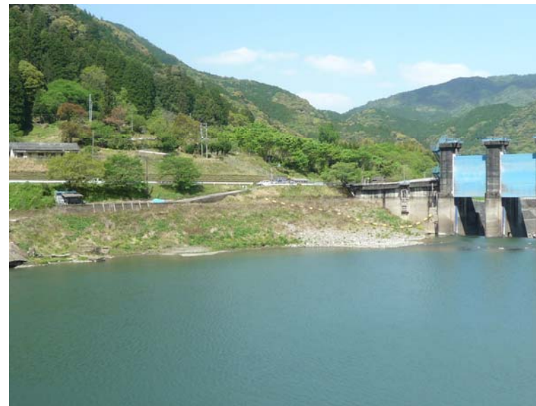
写真-7.4.1(1) 上流左岸側の護岸現状(遠景)
