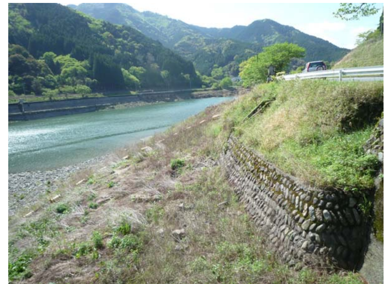
写真-7.3.1(2) 上流左岸側の護岸現状(近景)
