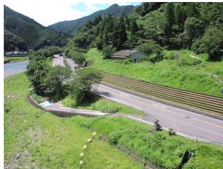
写真-7.4.1(2) 上流左岸側の護岸現状(近景)
