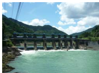
写真-1.1.1 荒瀬ダム
