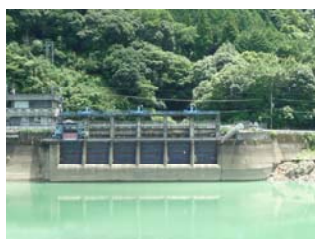
写真-1.1.2 取水施設
