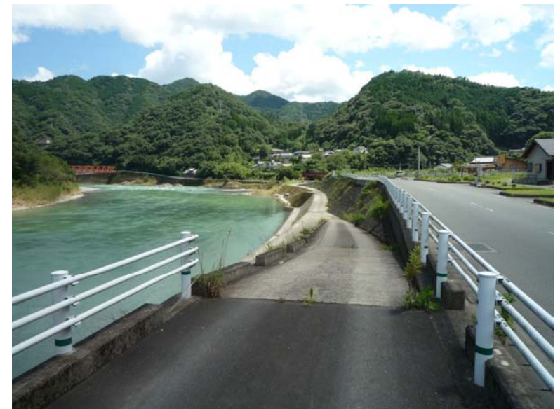
写真-7.4.2 安全対策(車止め)の事例
