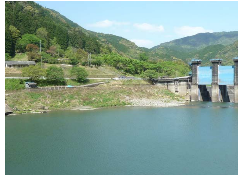
写真-7.3.1(1) 上流左岸側の護岸現状(遠景)
