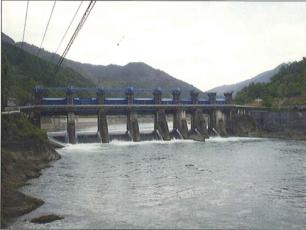
写真 2-3 現状の荒瀬ダム（平成 22 年 5 月、下流側から上流を望む）
