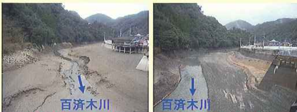
泥土除去前の状況 平成21年1月
