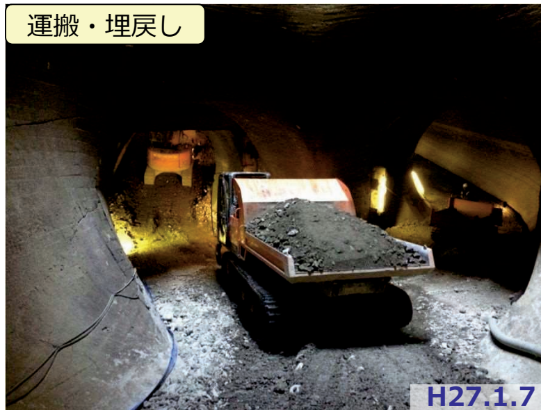
導水トンネル埋戻し第3期完了
