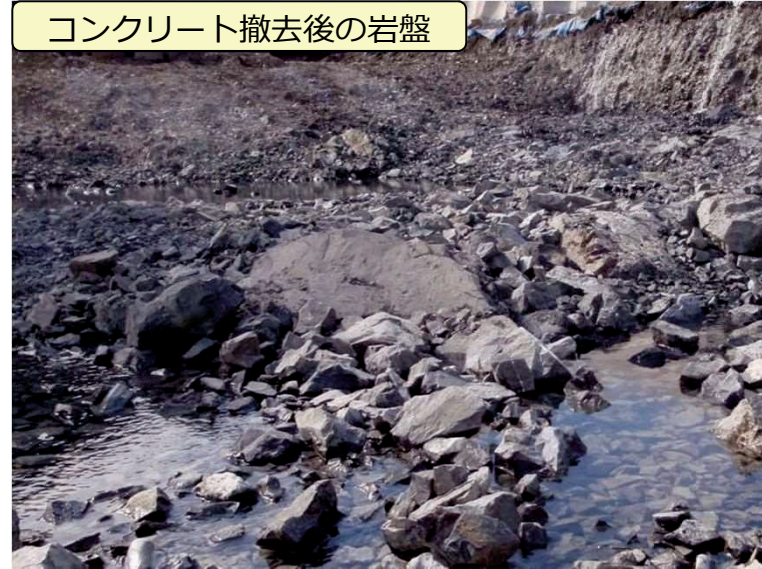
コンクリート撤去後の岩盤
