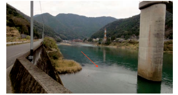
地点番号 St. 1-13 地点名 球磨川第一橋梁 調査日 平成26年3月8日
