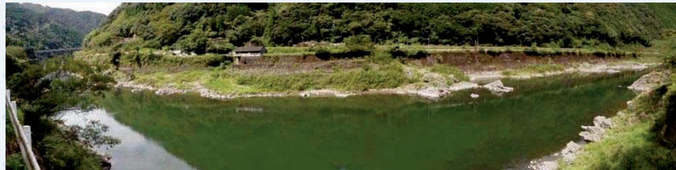
国道側から撮影(左が瀬戸石ダム)
