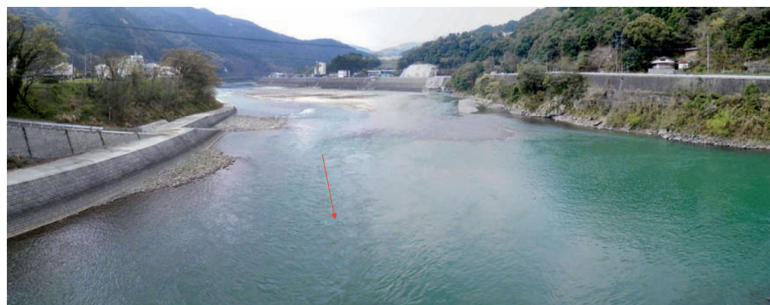
地点番号 St. 1-8 地点名 坂本橋 調査日 平成25年3月25日
