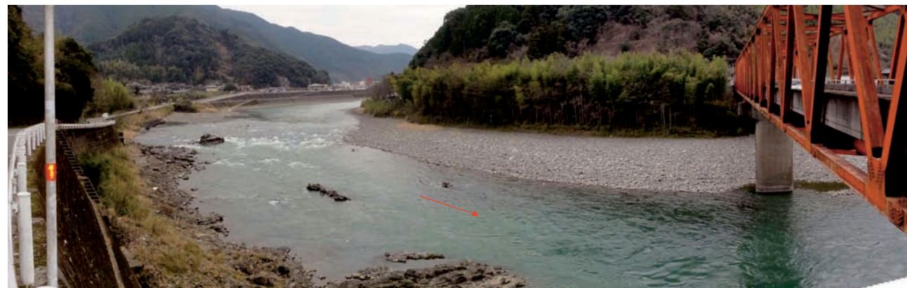
地点番号 St. 1-9 地点名 中谷橋 調査日 平成26年3月8日
