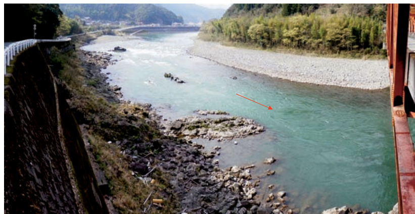
地点番号 St. 1-9 地点名 中谷橋 調査日 平成25年3月25日
