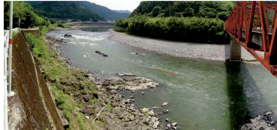
地点番号 St. 1-9 地点名 中谷橋 調査日 平成24年6月14日
