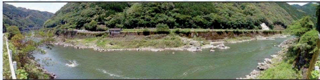
国道側から撮影(左が瀬戸石ダム)
