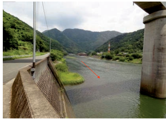
地点番号 St. 1-13 地点名 球磨川第一橋梁 調査日 平成24年6月14日
