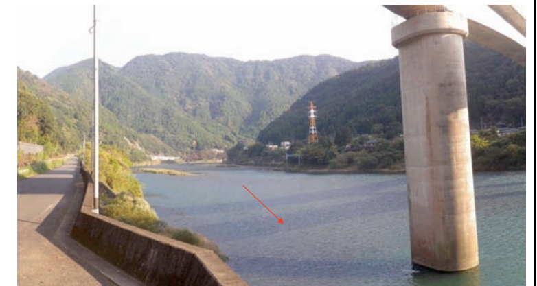
地点番号 St. 1-13 地点名 球磨川第一橋梁 調査日 平成26年11月18日
