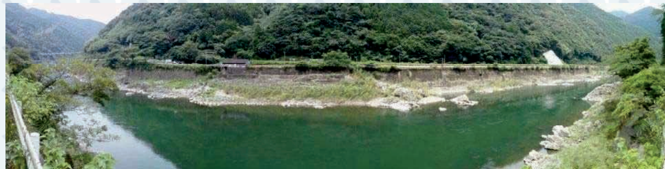
国道側から撮影(左が瀬戸石ダム)
