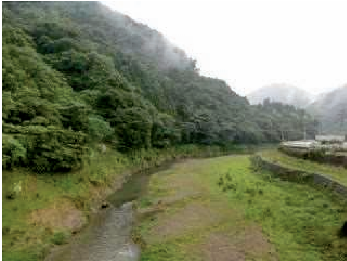
第2次水位低下後（平成25年6月下旬撮影）
