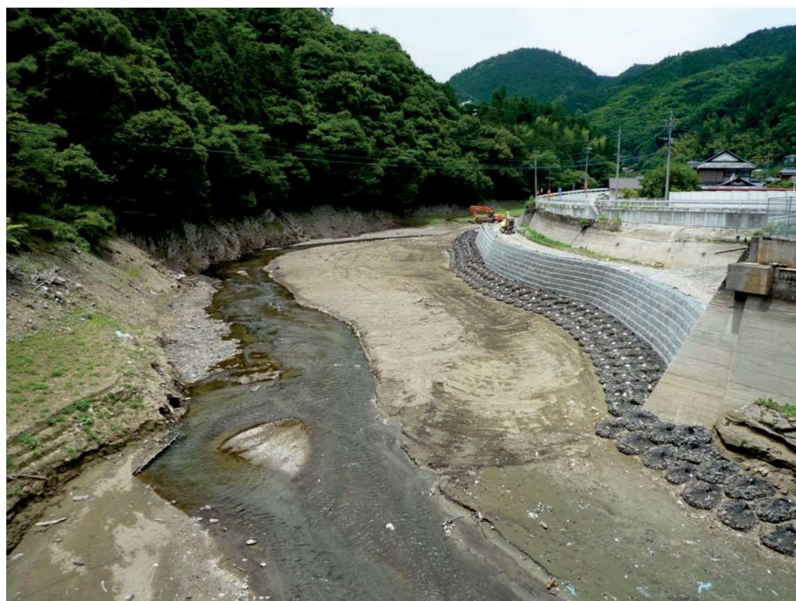
第1次水位低下後（平成22年6月撮影）
