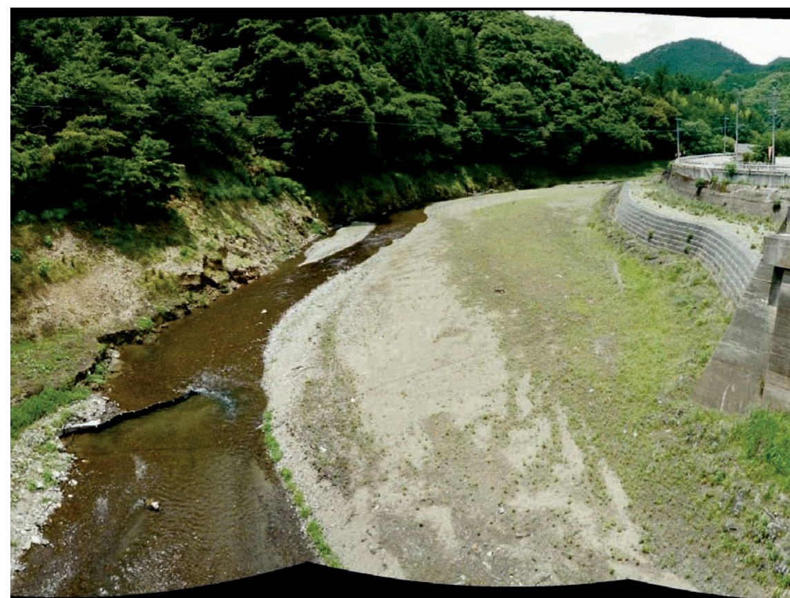
第1次水位低下後（平成24年6月撮影）
