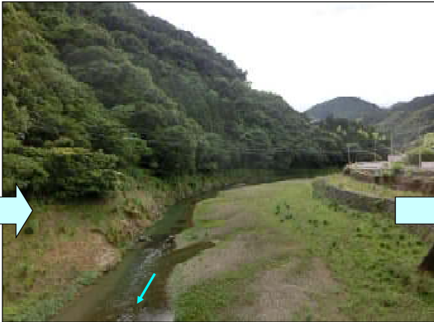
ゲート開放後(平成25年6月10日)
