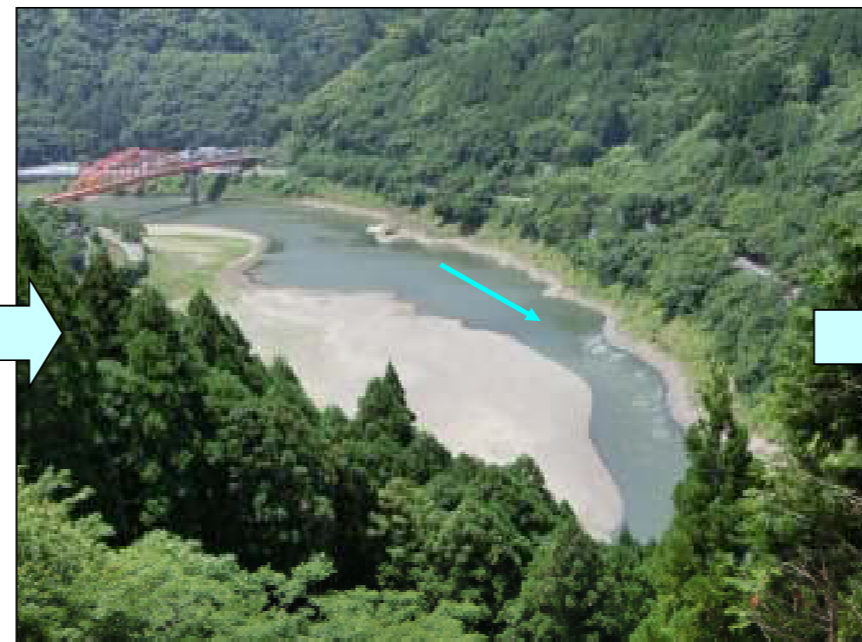
水位低下完了直後(平成25年6月17日)
