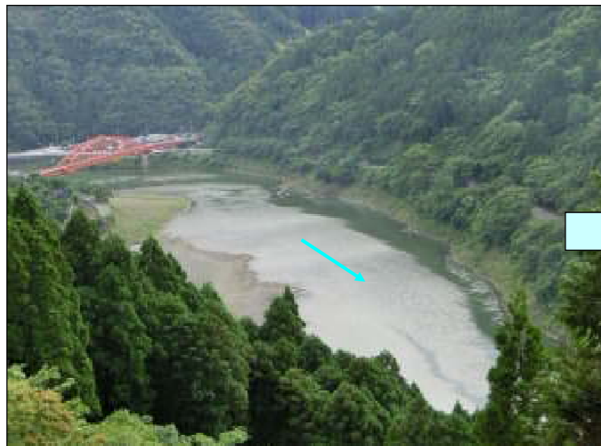
ゲート開放後(平成25年6月10日)
