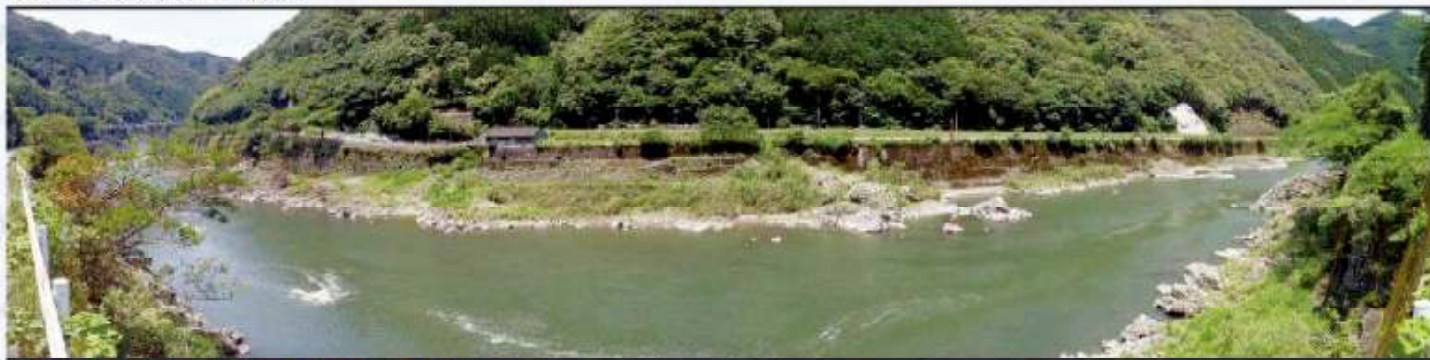
国道側から撮影(左が瀬戸石ダム)
