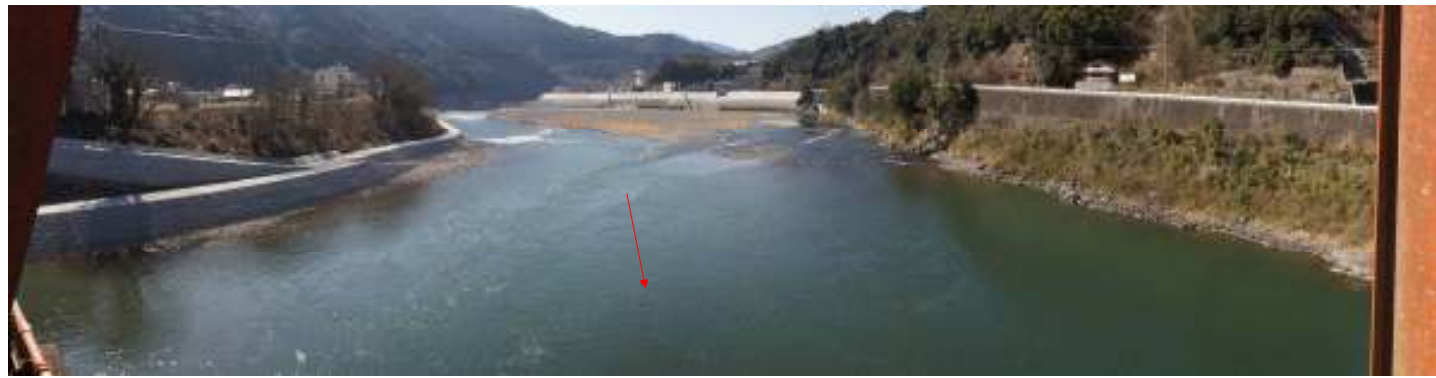
地点番号 St. 1-8 地点名 坂本橋 調査日 平成23年2月22日
