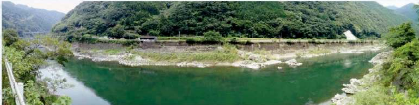
国道側から撮影(左が瀬戸石ダム)
