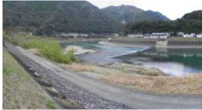
地点番号 St. 1-4 地点名 もぐり橋1 調査日 平成25年3月25日
