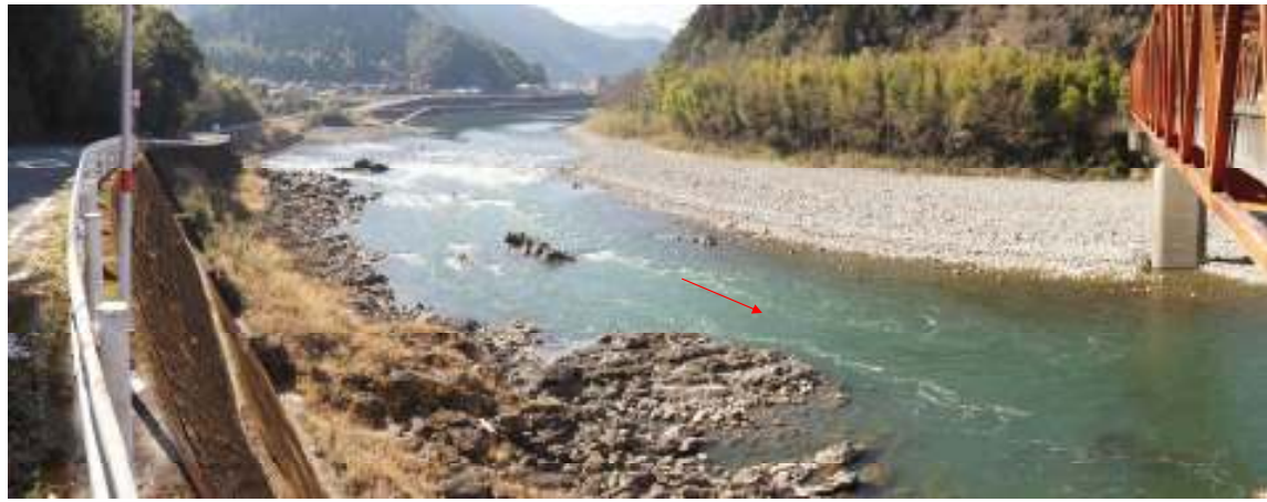
地点番号 St. 1-9 地点名 中谷橋 調査日 平成23年2月22日
