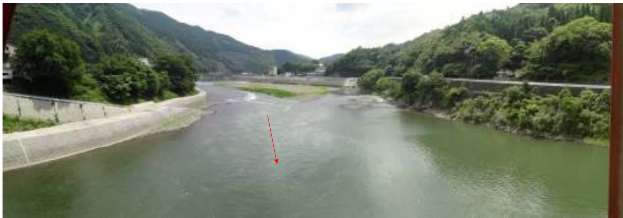
地点番号 St. 1-8 地点名 坂本橋 調査日 平成24年6月14日
