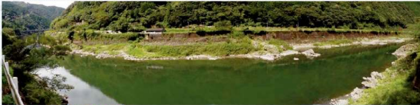
国道側から撮影(左が瀬戸石ダム)
