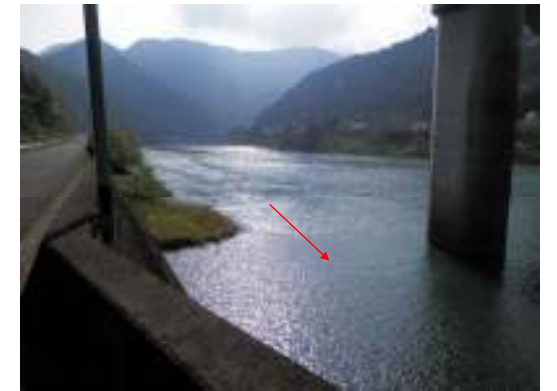
地点番号 St. 1-13 地点名 球磨川第一橋梁 調査日 平成25年3月25日
