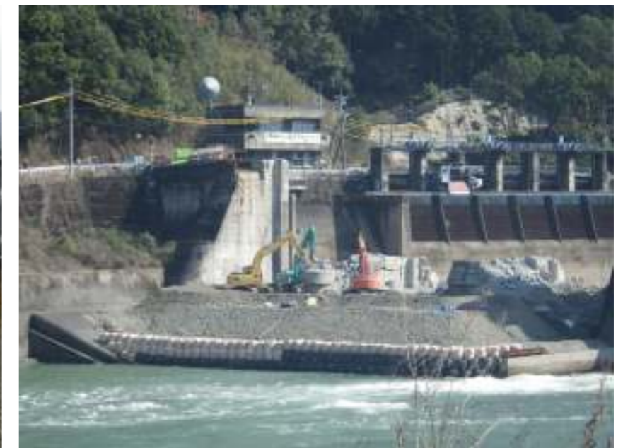
現地状況写真（大型ブレーカによる構造物取壊し）
