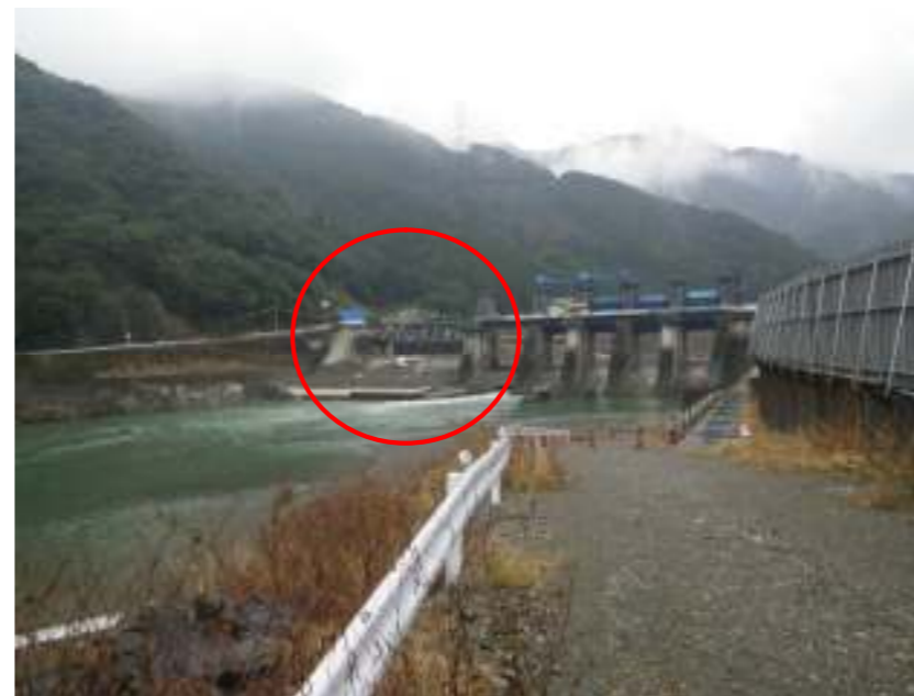
現地状況写真（発破）
