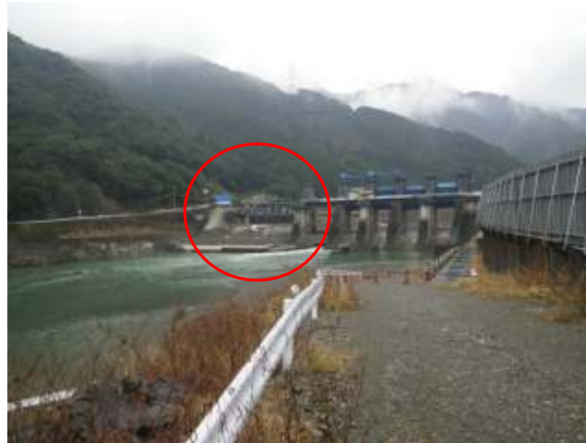
現地状況写真（発破）
